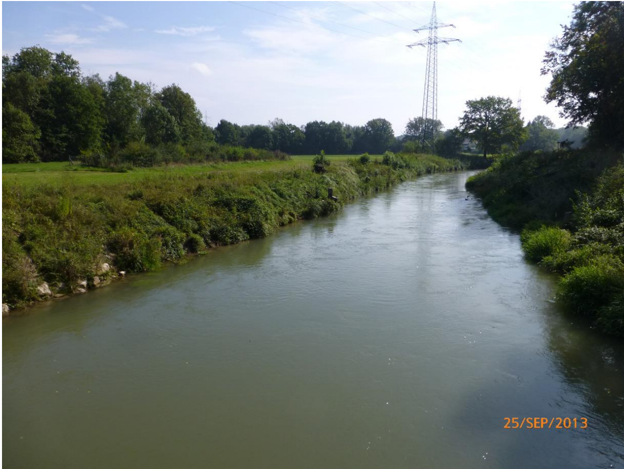
Abbildung 5 Illerkanal (Blick vom Teilungsbauwerk (Station 4+170) nach Süden)
