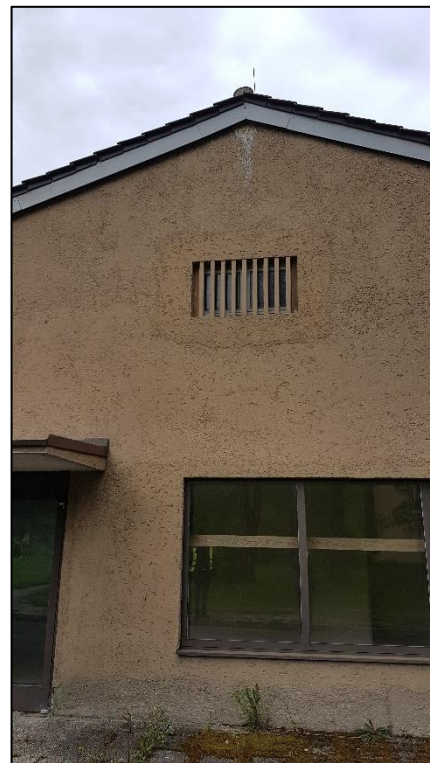
Abbildung 15: Kotspuren unterhalb der Verschalung im Dachbereich.
