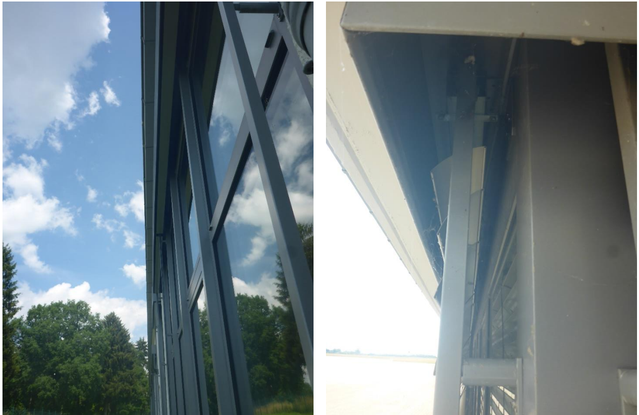
Abbildung 10: Fenstervorsprünge und Jalousiekästen am Gebäude 30
