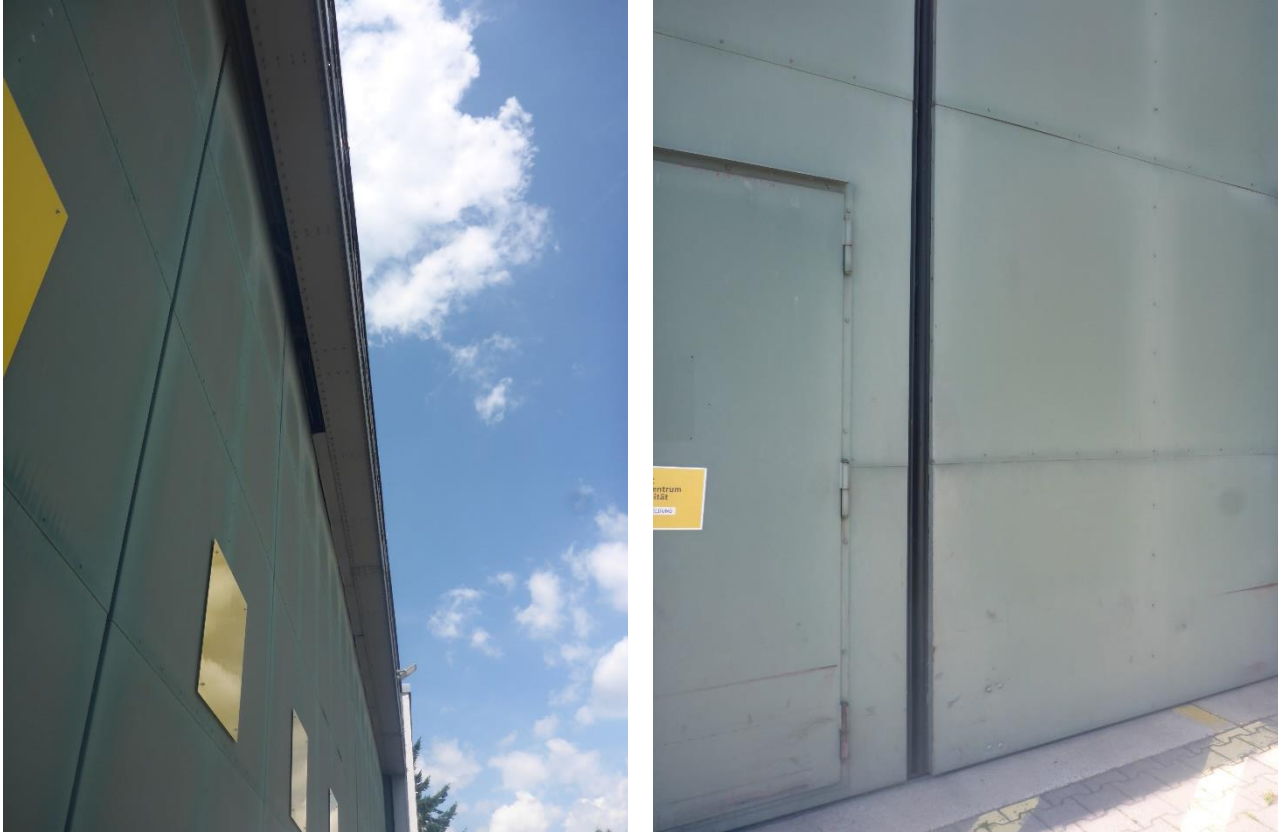
Abbildung 11: Spaltöffnungen oben am Hangartor (links) und zwischen den Torsegmenten (rechts)
