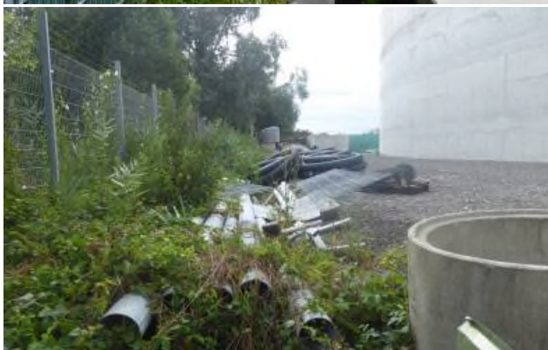
Abb. 12: Blick entlang des Zauns auf der Nordseite nach Osten.
