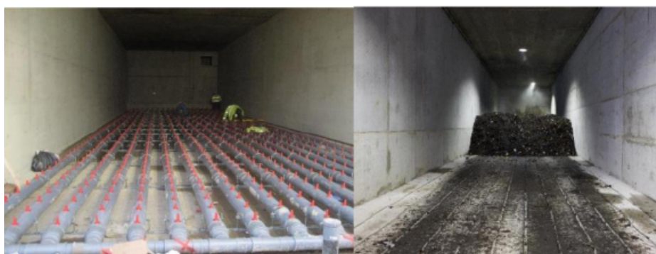
Abb. 11: Rottetunnel mit Spigotrohren (Bild 1 im Bau; Bild 2 im Betrieb)
