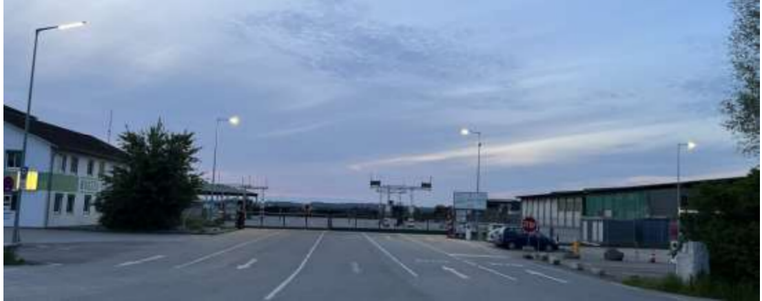
Abbildung 5. Wurzler Umwelt GmbH, Beleuchtungsanlagen im Bestand, messtechnische Bestandsaufnahme [8], Foto: Müller-BBM.
