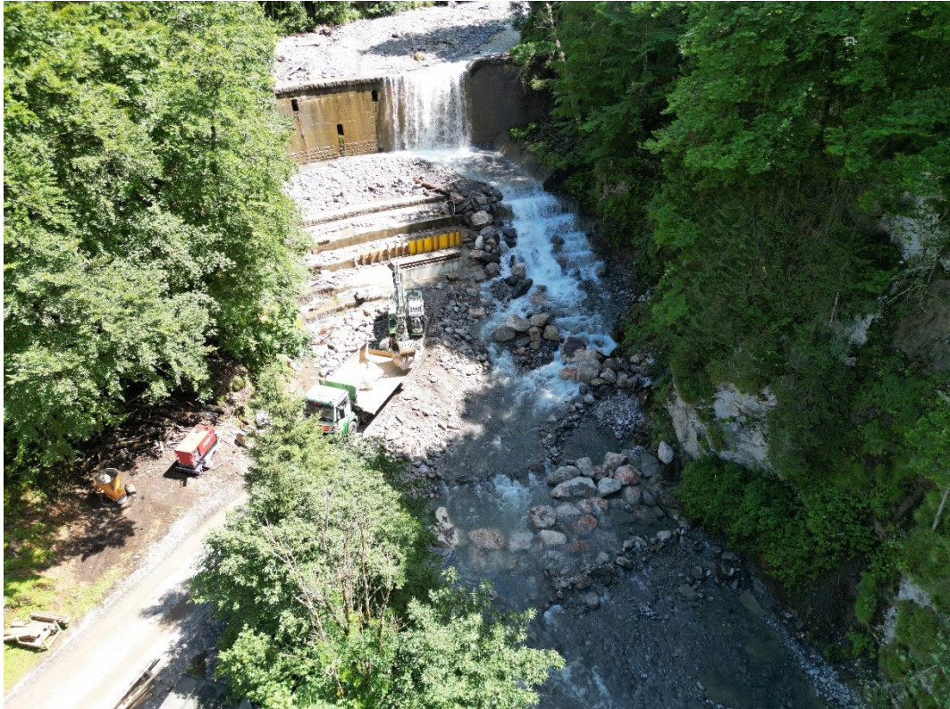
Abbildung 7: Absturzbauwerke mit anschließender Sohlsicherung (ITS Scheiber ZT GmbH, 2023)
