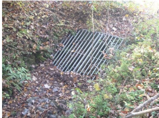
Abbildung 16: Einmündung in die Verrohrung
