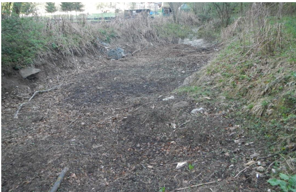
Abbildung 3.19: Bestehendes Geschieberückhaltebecken am Pletzgraben (Bau-km 0+315 bis Bau-km 0+327).
