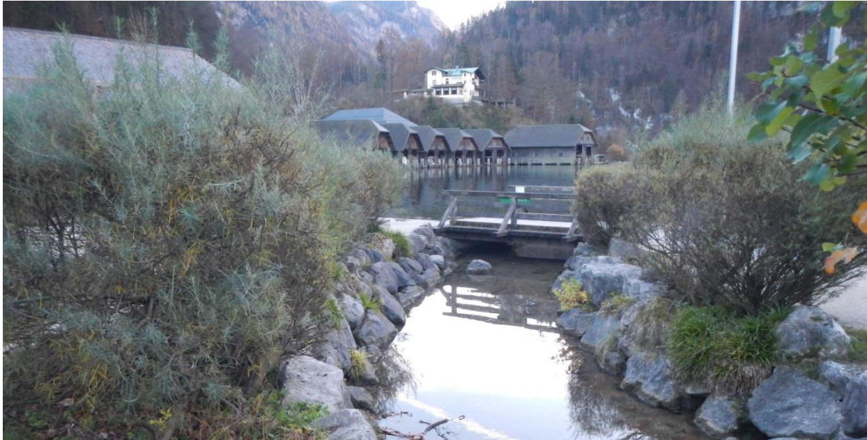
Abbildung 3.16: Mündungsbereich des Pletzgrabens in den Königssee. Fußgängersteg in Bildmitte.
