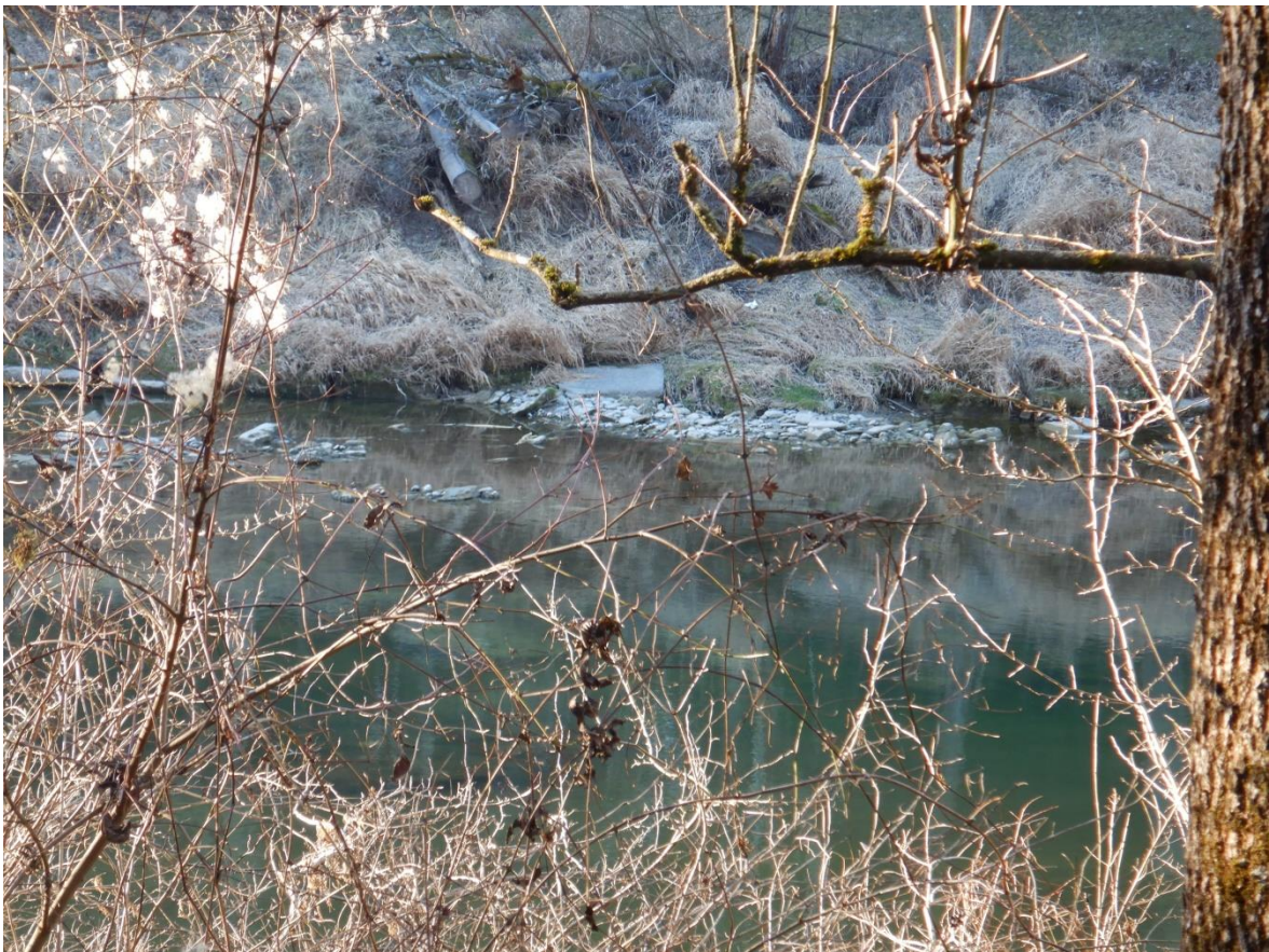
Abbildung 15: Aufgelockerte Uferbefestigungen unterhalb der Mooshauser Schwelle (BCE 01/20)
