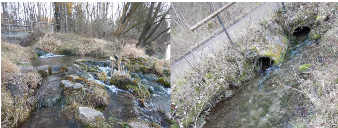
Abbildung 19: Die Mündung des Neuer Baches in die Iller und ein eingeschränkt durchgängiger Rohrdurchlass etwa 200 m stromauf (BCE 01/20)
