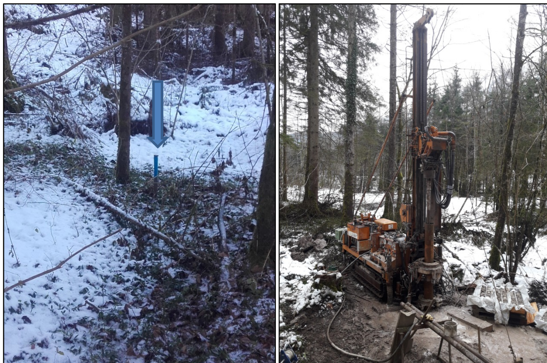
Abbildung 23: Position der Kernbohrung BH02/17 orographisch rechts der Saalach - Portalbereich
