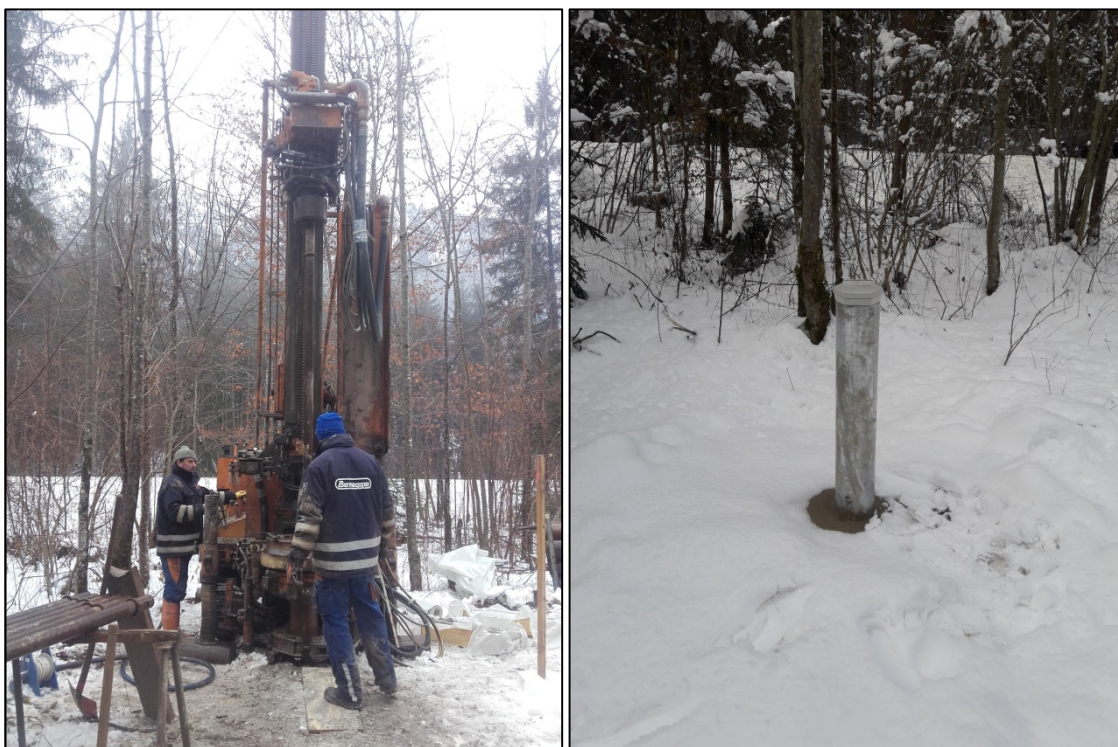
Abbildung 22: links: Position der Pegelbohrung BH01/17 orographisch links der Saalach; rechts: fertiggestellter Überflurpegel BH01/17
