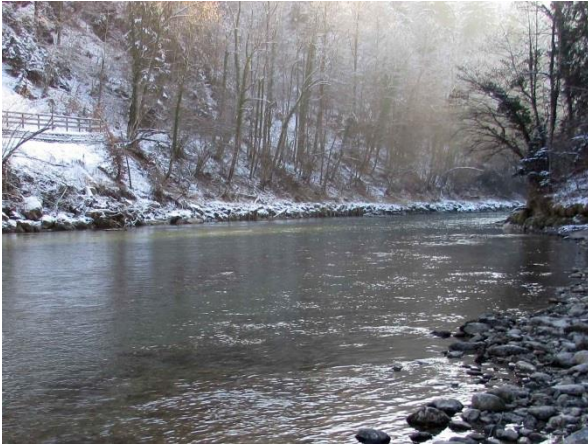
Abb. 10.12: Ufersicherung im Prallhang.
