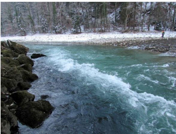
Abb. 10.14: Entlang der linksufrigen Ufersicherung hat sich ein Rinner mit anschließendem Kolk ausgebildet.
