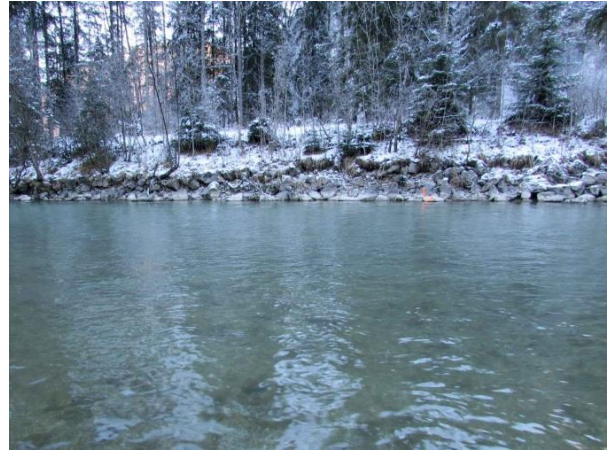
Abb. 10.8: Rechtsufriger Blockwurf im Abschnitt 1.
