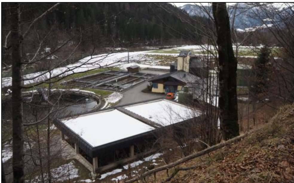
Abb. 4.6: Blick auf die Kläranlage von der Zufahrtsstraße zur Köstlerbrücke [Photo: Knoll, 16.01.2018]
