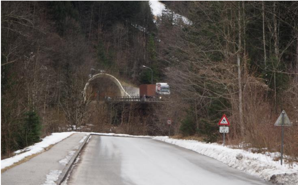
Abb. 4.7: Tunnelbauwerk an der B 178 Loferer Straße unmittelbar südlich des Geltungsbereichs
