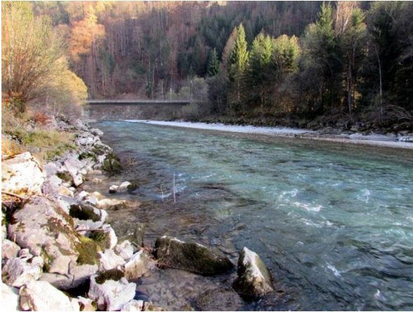
Abb. 10.2: Oberhalb der Straßenbrücke sind beide Ufer gesichert.
