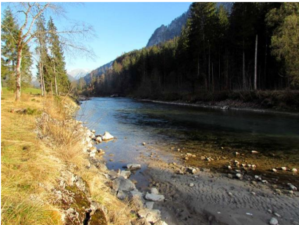
Abb. 4.9: Während das linke Ufer mit Blocksteinen verbaut ist, treten am rechten Ufer lediglich lokale Sicherungen mit Blockwurf auf.
