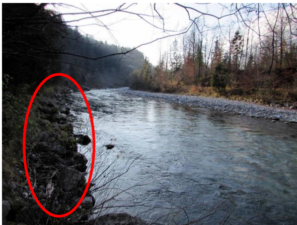
Abb. 4.44: Blockwurfsicherung am orographisch rechten Ufer flussabwärts der Brücke im Bereich der ARA Unken.
