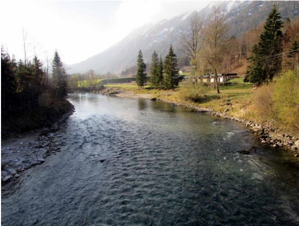
Abb. 4.13: Saalach bei der Kläranlage Unken mit flach ausgebildetem orographisch linken Ufer, Blickrichtung flussaufwärts.
