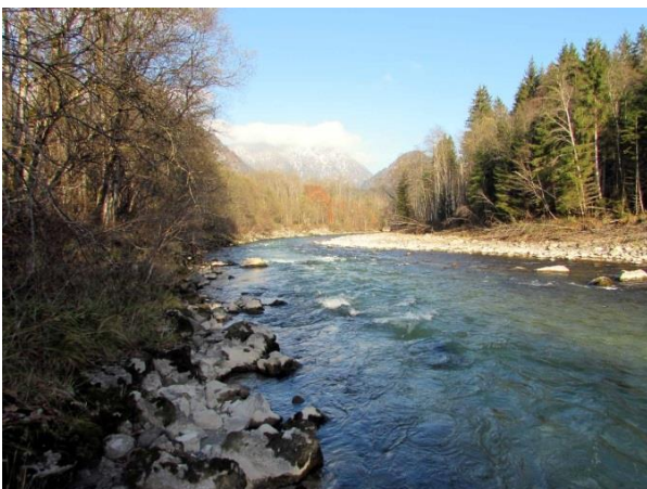
Abb. 4.5: Saalach flussabwärts der Agip-Tankstelle unterhalb der Straßenbrücke mit Blockwurf am orographisch linken Ufer und unverbautes rechtes Ufer.
