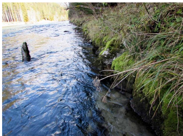
Abb. 4.22: Die österreichische Uferseite dürfte zwischen Melleck und Oberjettenberg überwiegend mit Blockwurf verbaut sein, der bereits überwachsen ist.
