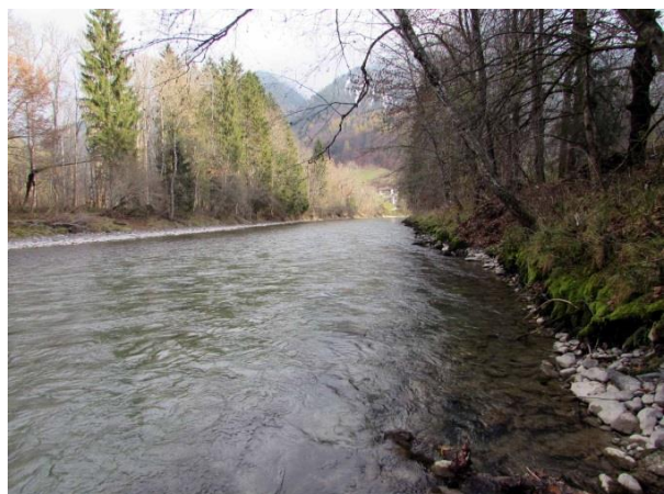
Abb. 4.32: Saalach oberhalb von Schneizlreuth mit überwachsenem Blockwurf am orographisch rechten Ufer, Blickrichtung flussabwärts.
