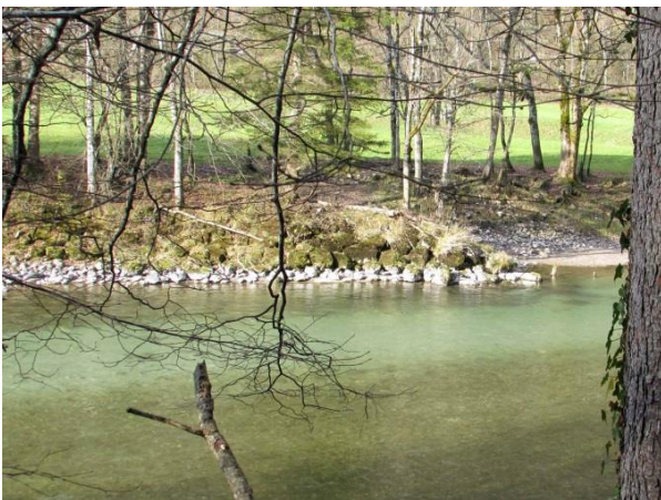
Abb. 4.29: Lokale buhlenartige Struktur aus Steinblöcken.
