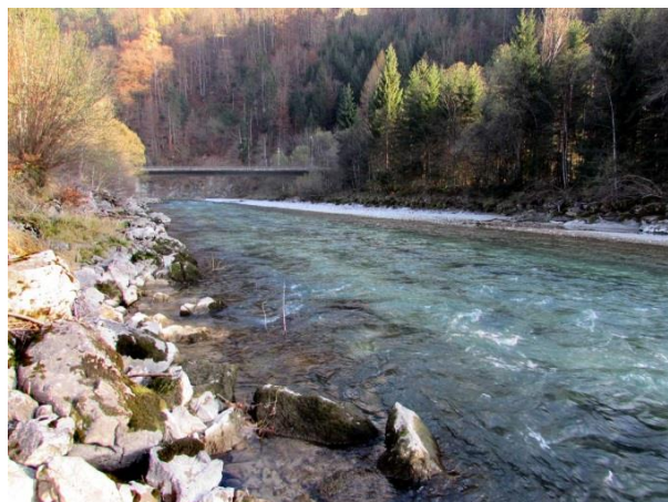
Abb. 4.2: Saalach oberhalb der Straßenbrücke der B178 mit Ufersicherung durch Blockwurf und vorgelagerten Schotterbänken, Blickrichtung flussabwärts.
