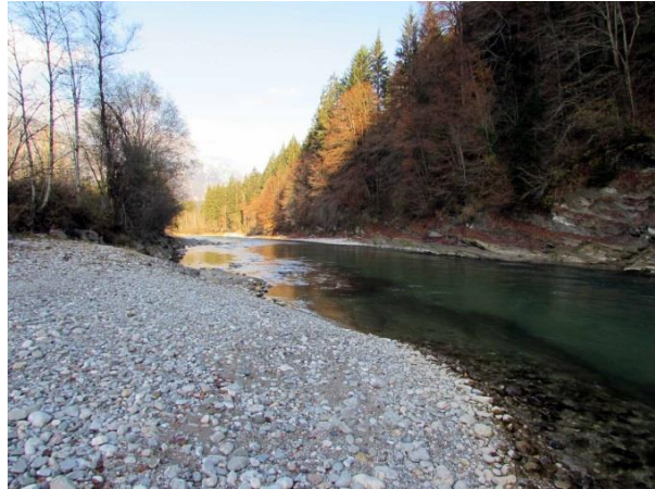
Abb. 4.4: Flussabwärts der Straßenbrücke der B178 tritt an den Ufern und in der Sohle anstehender Fels hervor, Blickrichtung flussabwärts.
