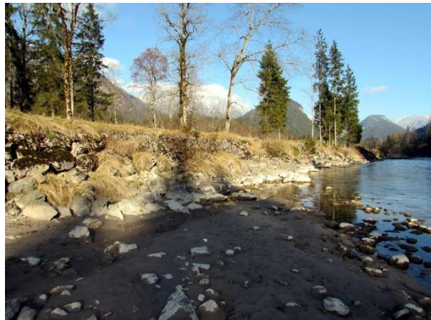
Abb. 4.10: Sicherung mit Blockwurf am orographisch linken Ufer flussabwärts der linksseitigen Felsblöcke.
