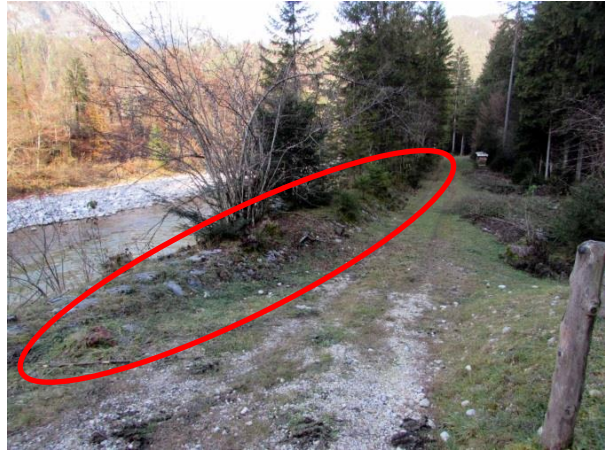
Abb. 4.43: Aufgesetzter Uferdamm aus Steinblöcken flussabwärts der Brücke im Bereich der ARA Unken.
