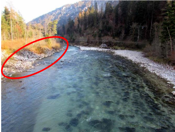
Abb. 4.42: Das orographisch linke Ufer ist von der Brücke im Bereich der ARA Unken flussabwärts (Mündungsbereich des Steinbaches) mit Blockwurf verbaut.
