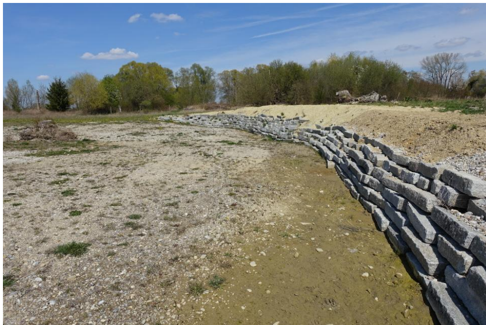
Foto 18 Ausgleichsfläche östlich Deponie, Südabschnitt, Blickrichtung Nord, 19.04.2022: Neu angelegte Trockenmauer mit Flachtümpel im Zentrum, Frühlingsaspekt
