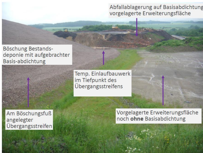
Abbildung 9-30 Temporäre Niederschlagsentwässerung – Übergangsstreifen (Ausführungsbeispiel)
