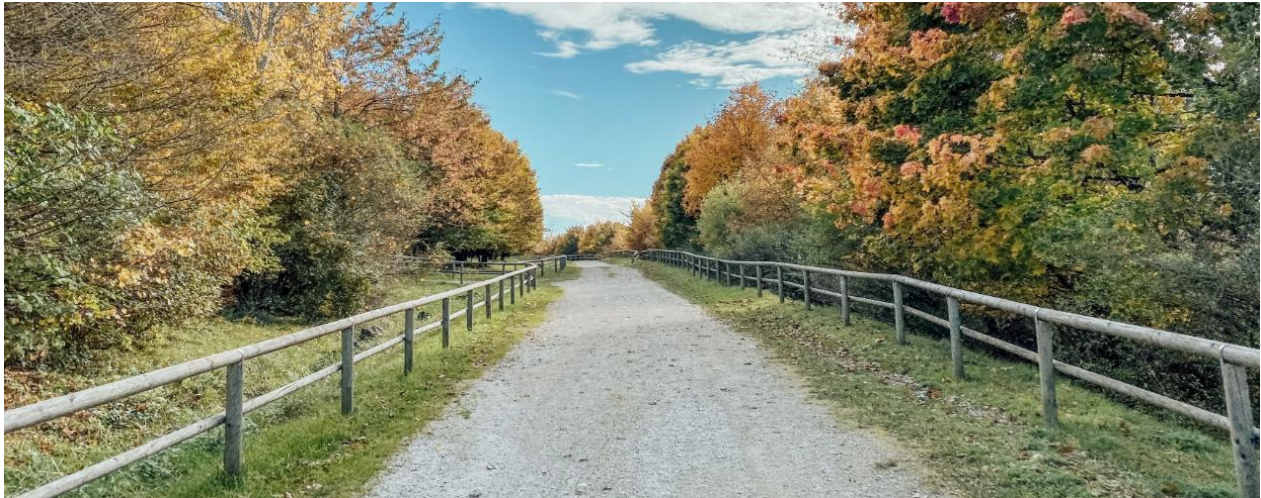
Abbildung 9-28 seitlicher Entwässerungsgraben (Bestand Deponie Augsburg-Nord)
