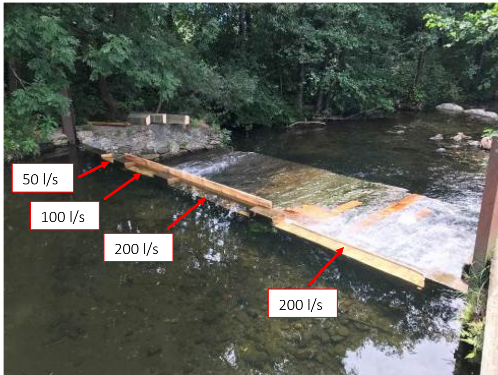
Abbildung 4: Wehranlage zur Einstellung der Restwassermenge mit verschiedenen Öffnungen
