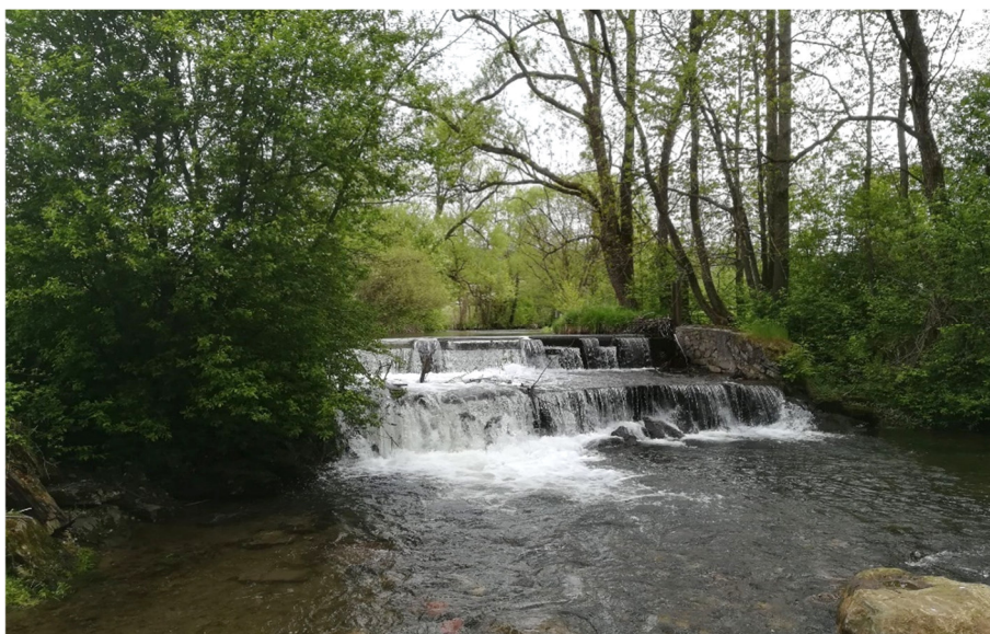
Abb. 12: Bestehendes Stauwehr. Vollständiger Rückbau. Der Neubau erfolgt weiter flussaufwärts.
