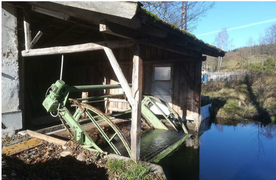
Abb. 17: Einlauf mit Fangrechen der bestehenden Wasserkraftanlage.
