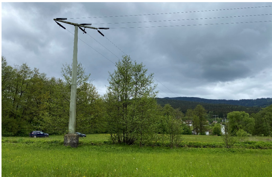
Abb. 15: Freileitung im Bereich des Oberwasserkanals. Stellenweise Uferbegleitgehölze.
