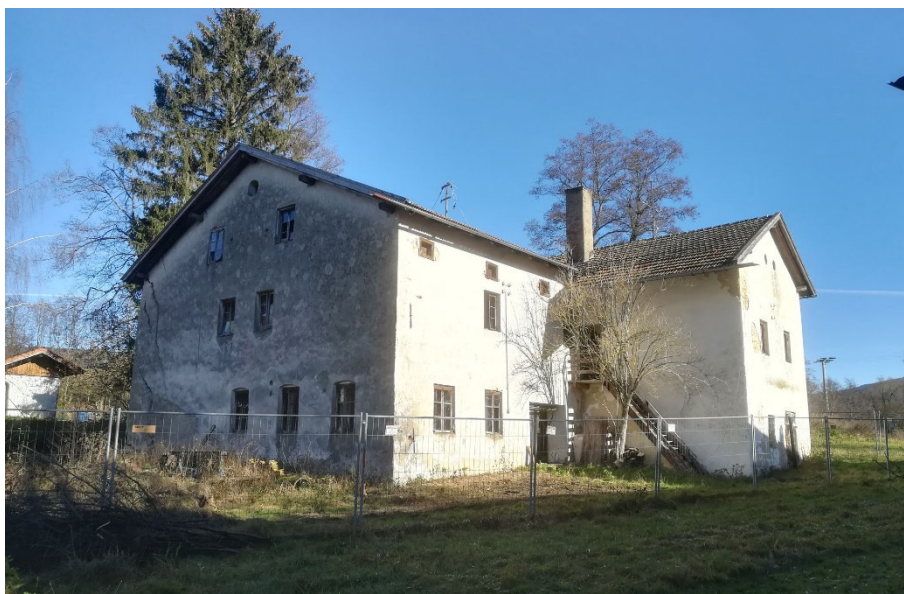
Abb. 18: Betriebsgebäude der Wasserkraftanlage. Vollständiger Rückbau.
