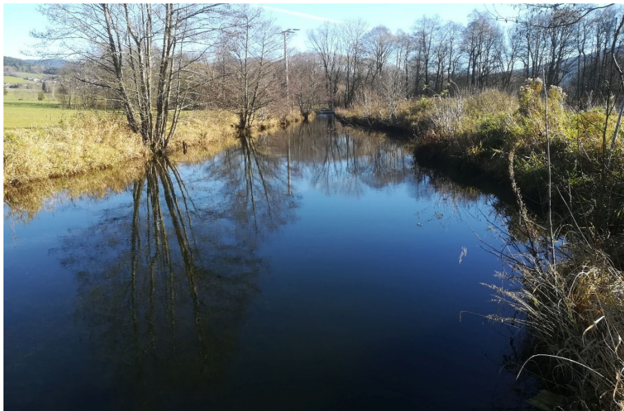
Abb. 14: Blick in Richtung Osten auf den Oberwasserkanal.
