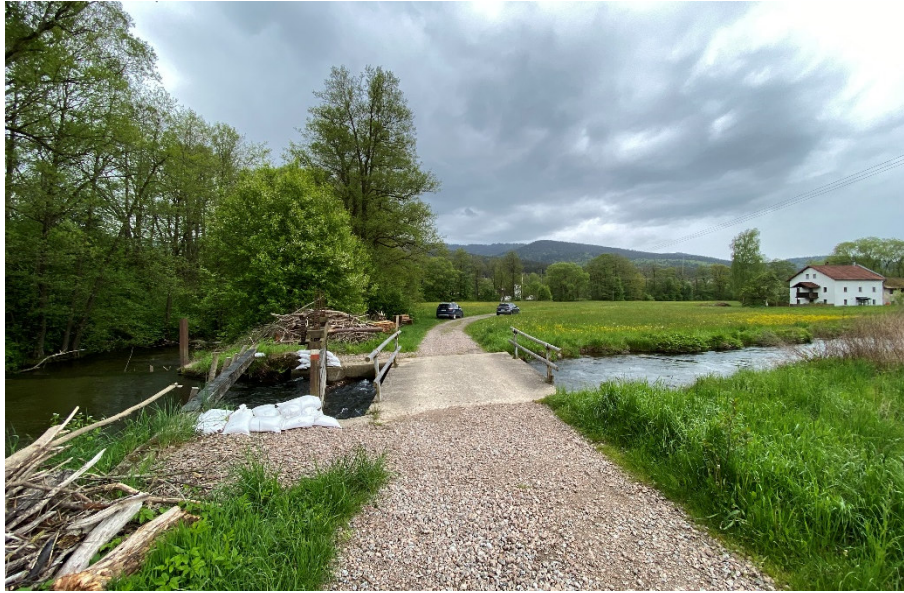
Abb. 13: Überfahrt Oberwasser- kanal und Ausleitstelle aus dem Weißen Regen oberhalb der bestehenden Wehranlage.
