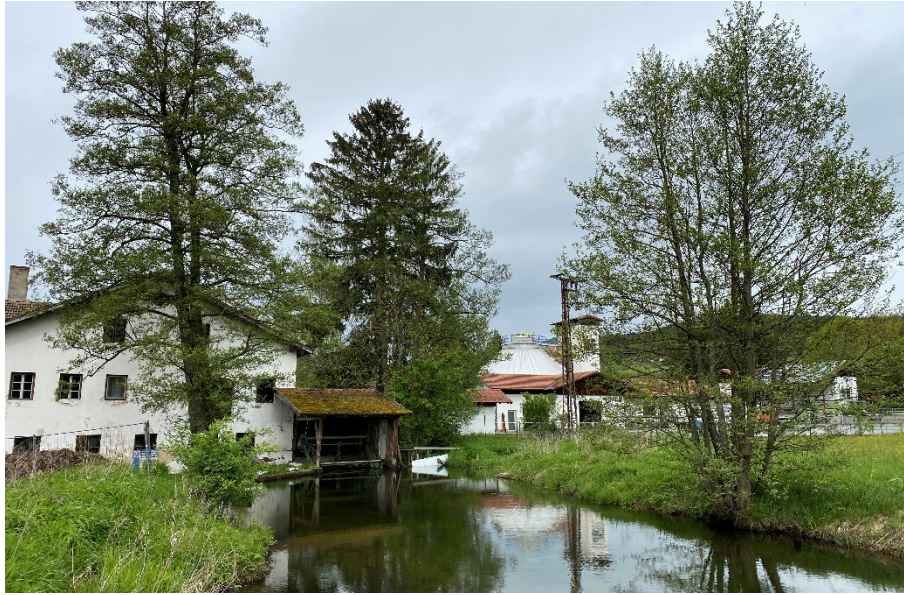
Abb. 16: Blick Richtung nach Westen auf den Oberwasserkanal mit Betriebsgebäude WKA. Kläranlage Arrach im Bildhintergrund.
