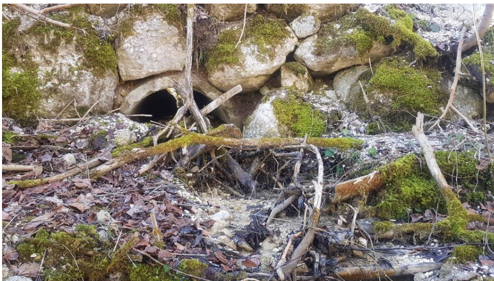
Photo 5.76: Namenloses Gerinne, km 0,270 flussauf, Verrohrung
