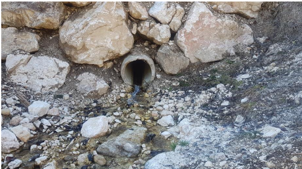
Photo 5.74: Namenloses Gerinne, km 0,340 flussauf, Verrohrung
