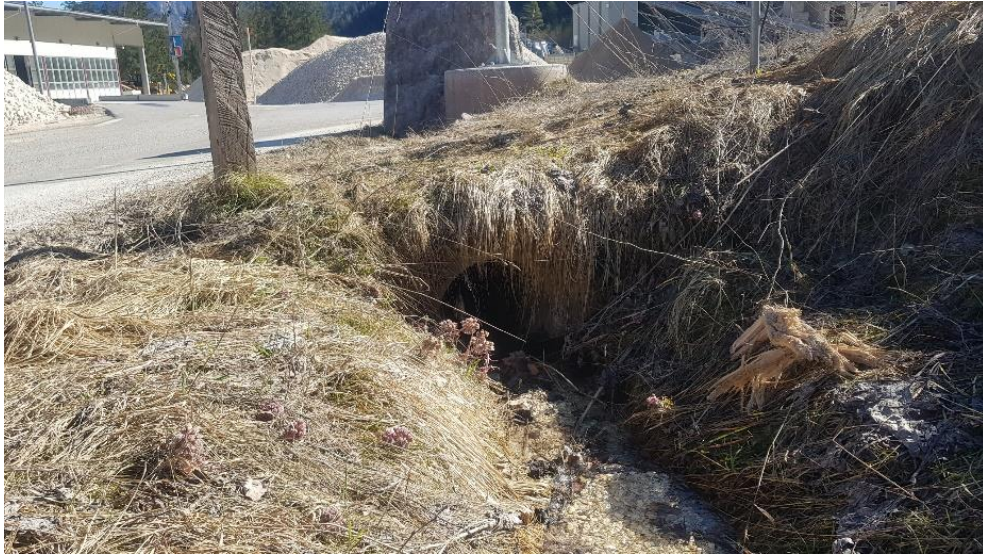
Photo 5.81: Namenloses Gerinne, km 0,170 flussab, Verrohrung
