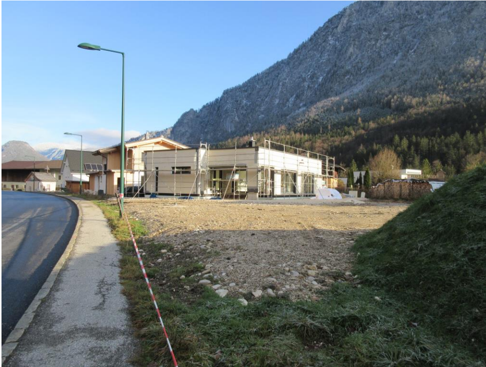
Photo 5.31: Wohngebäude in Bau Niederland 290 (im Plan Nr. 36)
