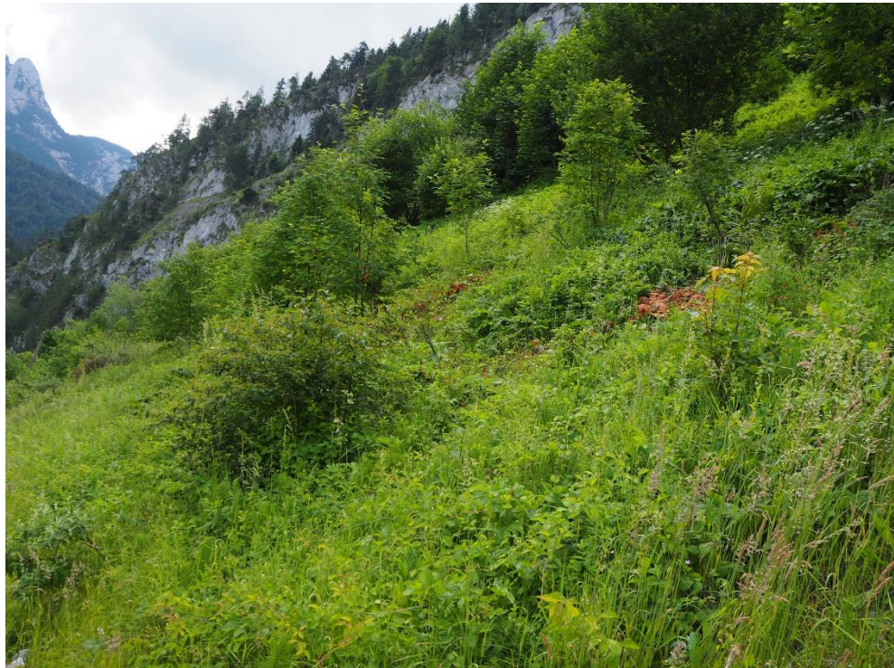
Photo 5.111: Abbauendböschung im Abbaufeld „Pfannhaus 1“: Entwicklungsdauer ca. 10 Jahre
