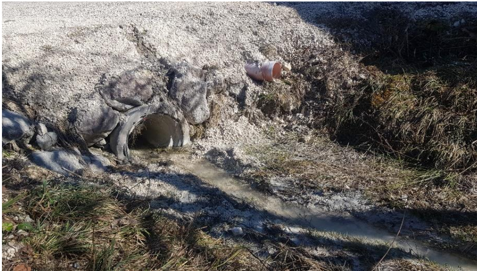
Photo 5.83: Namenloses Gerinne, km 0,086 flussab, Verrohrung
