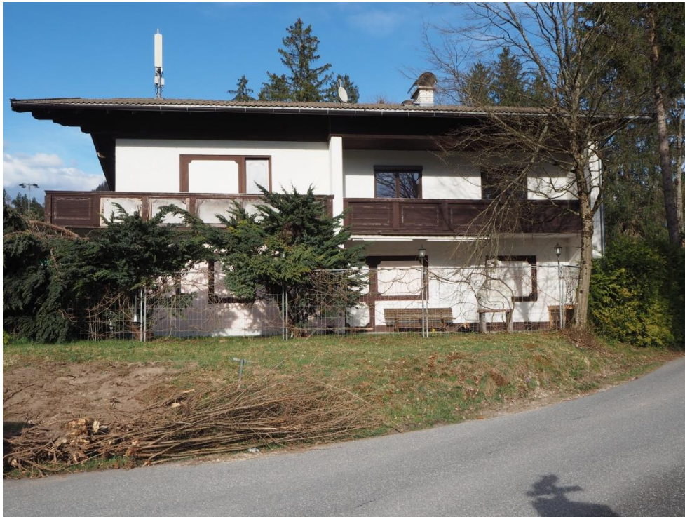
Photo 5.7: Wohngebäude Niederland 107 (ehem. Evita, dzt. unbewohnt und gewerblich genutzt; im Plan Nr. 6)
