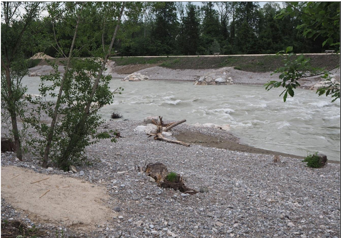
Abb. 17 Flussaufweitung Saalach in Wals-Siezenheim, Erosionssicherung der Ufer mit Buhnen. Fotos: Flatscher (oben) u. Knoll, REGIOPLAN INGENIEURE (unten), 27.05.2019
