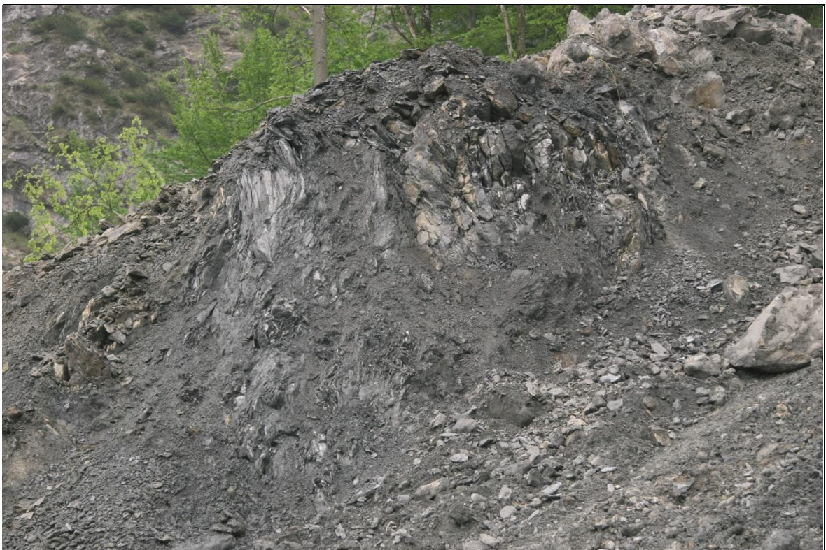
Abb. 5 Stillgelegter Abbau „Kuppe 710“: ca. 10 m mächtige, steil stehende Dachsteinkalk-Lamelle (oben, im Bereich Bagger); südlich davon im Bereich der Deckengrenze steil SSO- bis NNO-einfallende, wellig verfaltete, zerscherte Tonschiefer, Mergelkalke und Dolomite der Nordalpinen Raibler Schichten. 21.05.2008
