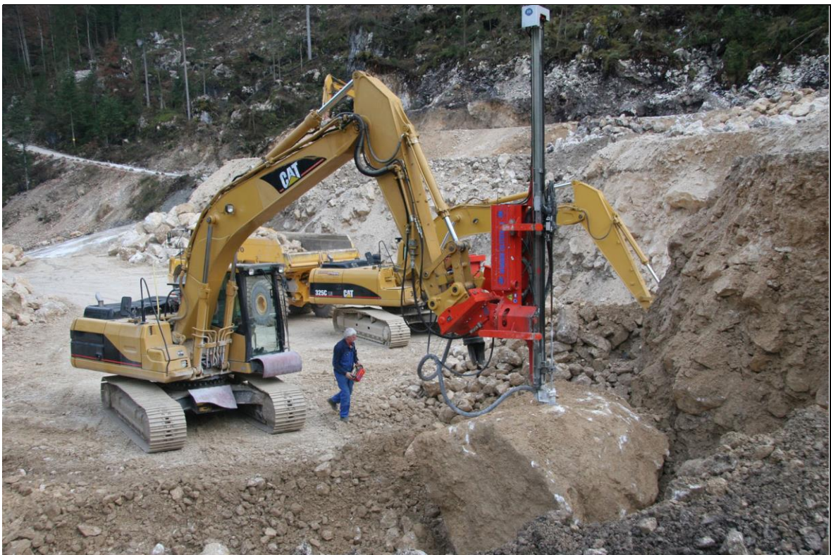
Abb. 24 Abbau „Köstlerwald I“, oben: Freilegen eines Großblocks mit Baggern von zwei Arbeitsetagen 600/605 im Hoch- u. Tiefschnitt. 02.11.2016
