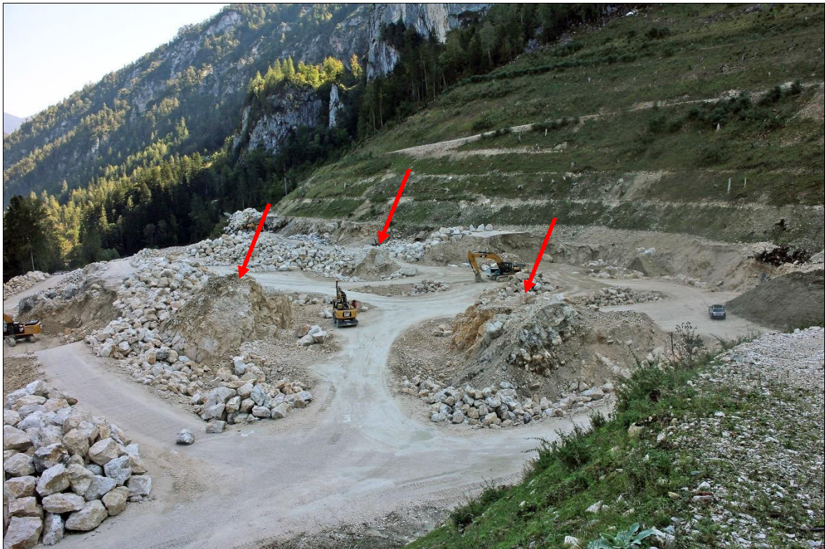
Abb. 6 Abbau Köstlerwald mit mehreren Abbauörtern auf ET 587 u. 583. Großblöcke (rote Pfeile) mit Kantenlängen bis zu 50 m müssen über mehrere Arbeitsetagen sukzessive freigelegt werden. 3:4 geneigte, rekultivierte Endböschung im Lockergestein. 17.09.2018
