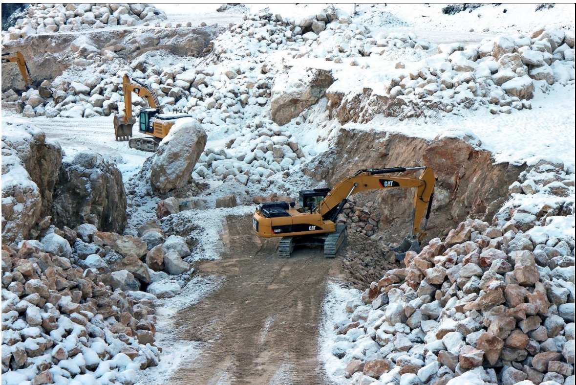
Abb. 23 Abbau „Köstlerwald I“: Hereingewinnen u. Abfördern von Lockergestein auf ET 593: der Bagger arbeitet sicher von einem erhöhtem Arbeitsplanum unter Ausbildung einer Fallmulde am Böschungsfuß. 13.12.2017
