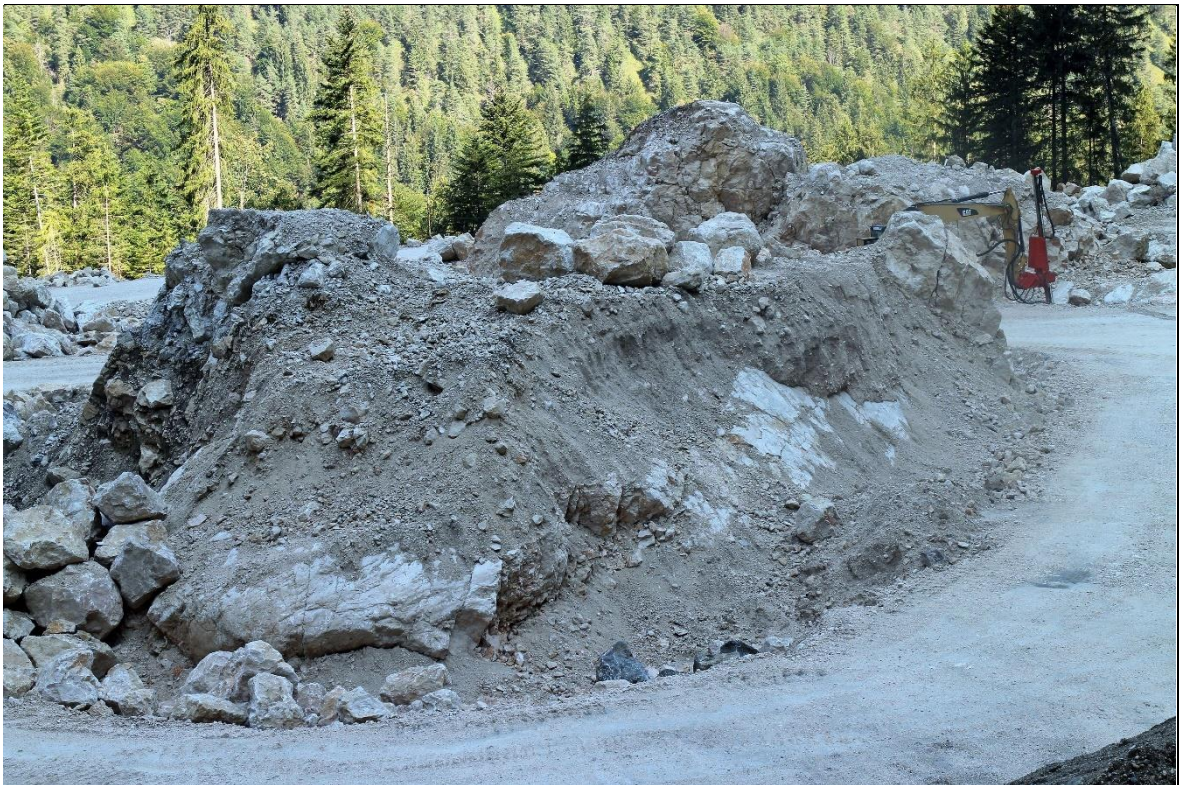
Abb. 7 Freigelegte Großblöcke bis ca. 30 m Kantenlänge
