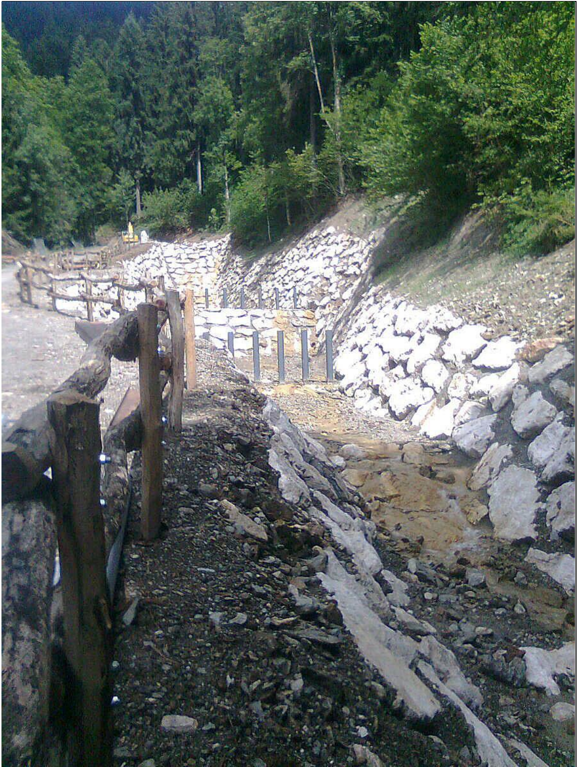
Abb. 19 Wildbachverbauung mittels Ufer- u. Sohlsicherung und Kaskaden in Kirchberg in Tirol, WLV-Gebietsbauleitung Wörgl. Foto: Flatscher
