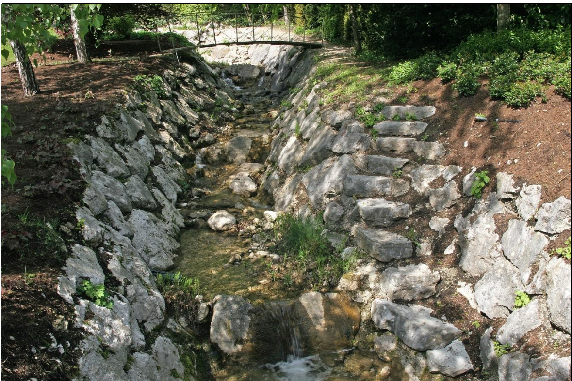
Abb. 16 Verbauung Saubach St. Gilgen 2004. Foto: Feitzinger, 18.05.2019
