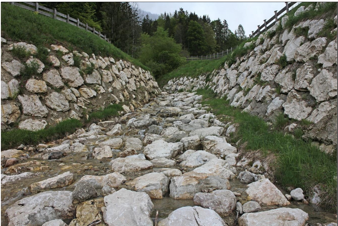
Abb. 20 Geschiebedosiersperre mit Einlaufbauwerk, Kirchbach in Unken. Fotos: Feitzinger, 14.05.2019
