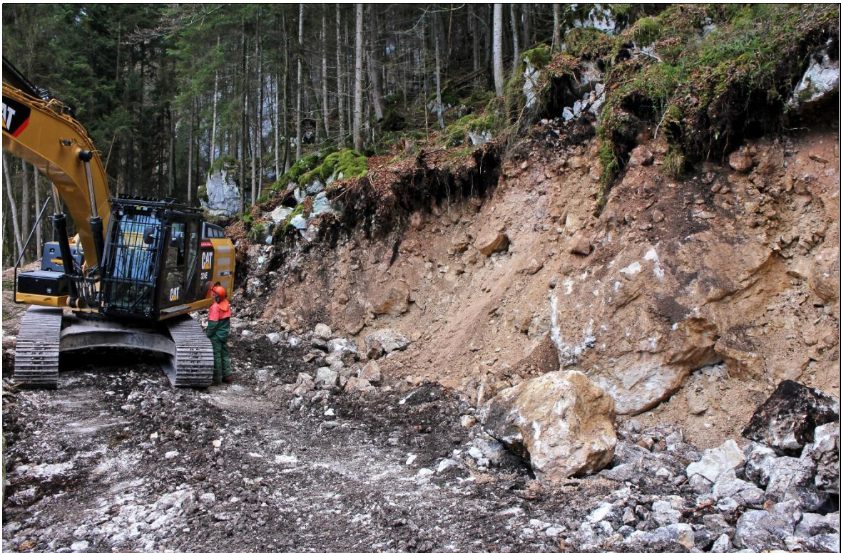
Abb. 27 Bergbaustraße Pfannhaus, Lockergesteinsabtrag zur Herstellung des bergseitigen Böschungseinschnitts. 14.12.2016
