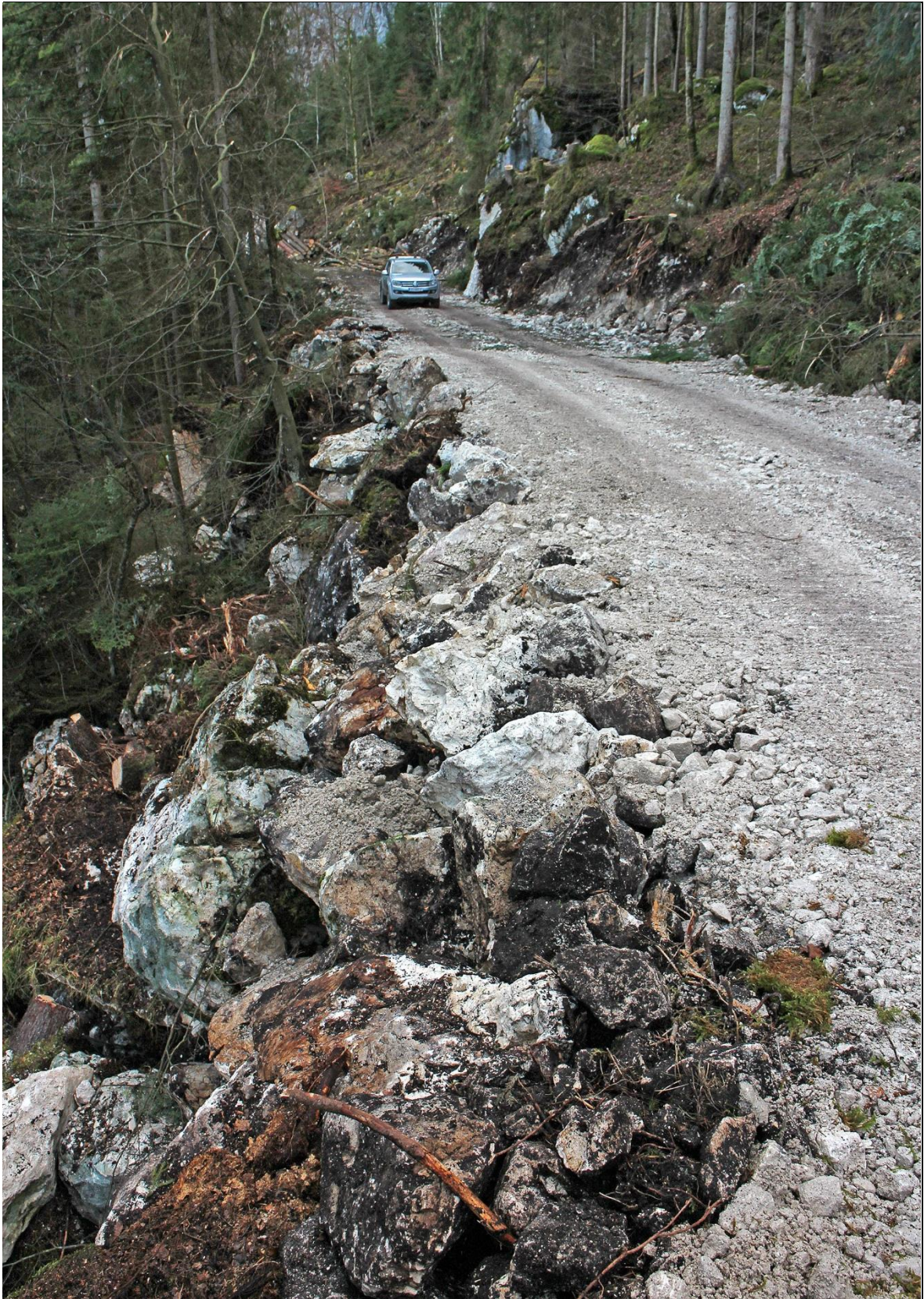
Abb. 28 Bergbaustraße Pfannhaus, im Vordergrund erkennbare Steinschichtung an der talseitigen Böschung. 14.12.2016
