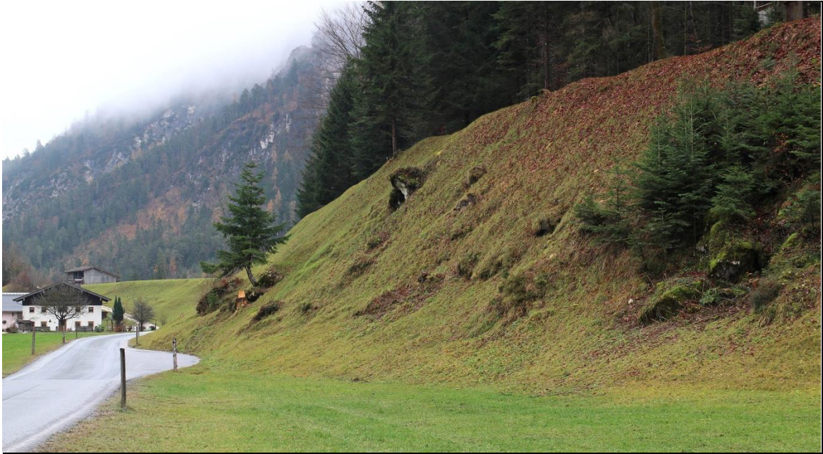
Abb. 26 Oben: großteils 1:1 steile Lockergesteinsböschung an der Zufahrtstraße westlich Köstlergut.
