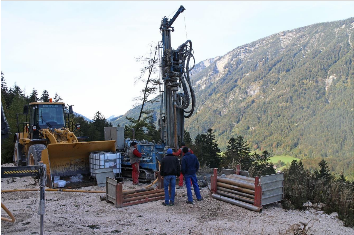
Abb. 9 Abteufen von Bohrung K2/1 in der Kehre der neuen Forststraße, 668 m Sh. 13.10.2016
