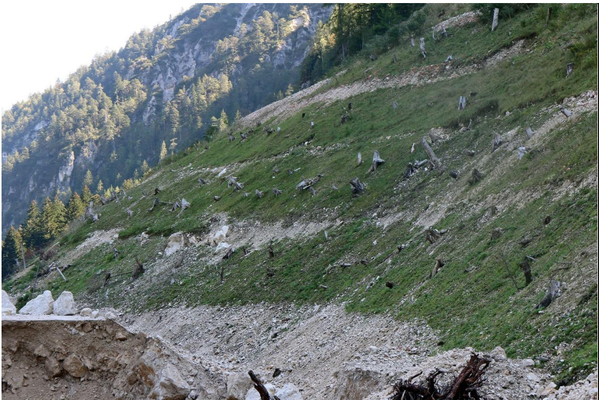
Abb. 22 Abbau „Köstlerwald I“: in einem Neigungsverhältnis 3:4 hergestellte, großteils rekultivierte, mit Wurzelstöcken bewehrte Endböschung über ET 605 (oben, 13.10.2016) u. ET 593 (unten, 17.09.2018)
