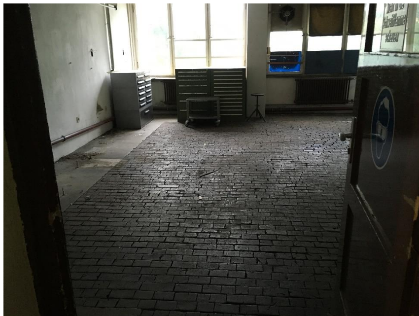
Abb. 6: Maschinenraum (Holzstöckelboden, MP17)
