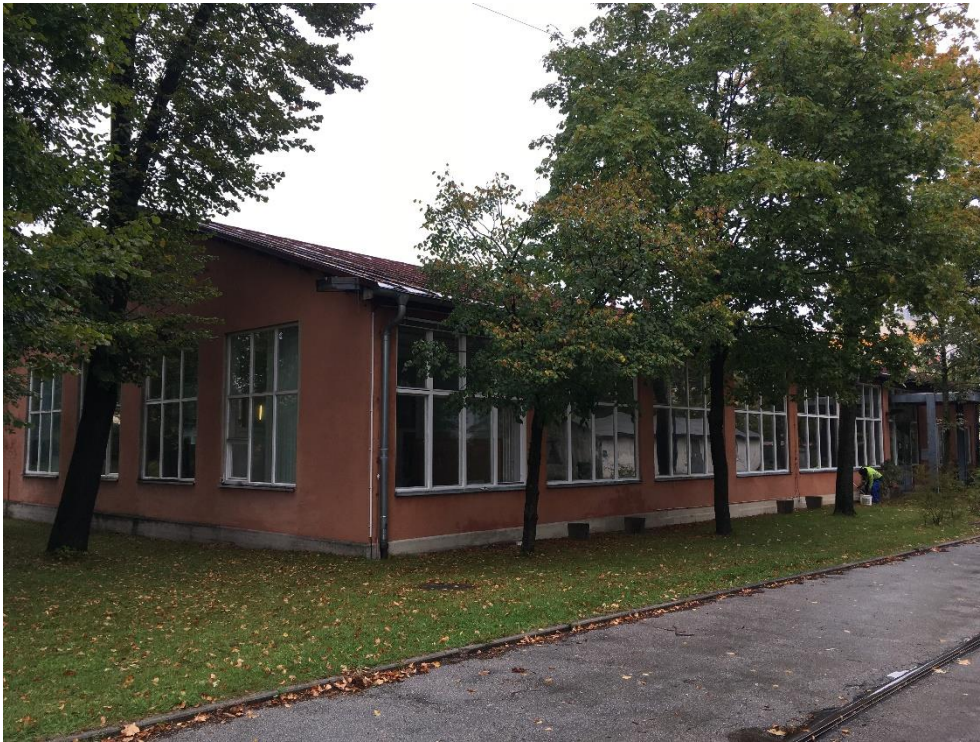
Abb. 1: Außenansicht Automatenraum (Südseite)
