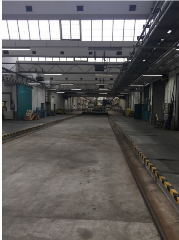
Abb. 5: Hauptwerkstätten (Shedhallen), Anlage Nr. 4, (Innenansicht)
