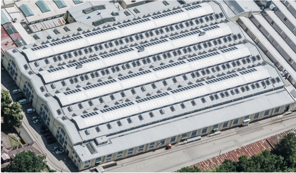
Abb. 9: Hauptwerkstätten (Montagehalle), Anlage Nr. M/4
