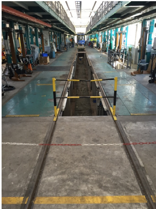
Abb. 6: Hauptwerkstätten (Shedhallen), Anlage Nr. 4, Montagegruben
