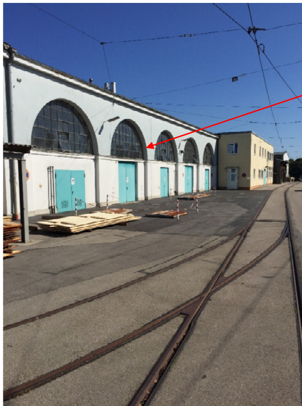
Abb. 14: Kesselhaus, Anlage Nr. 6
