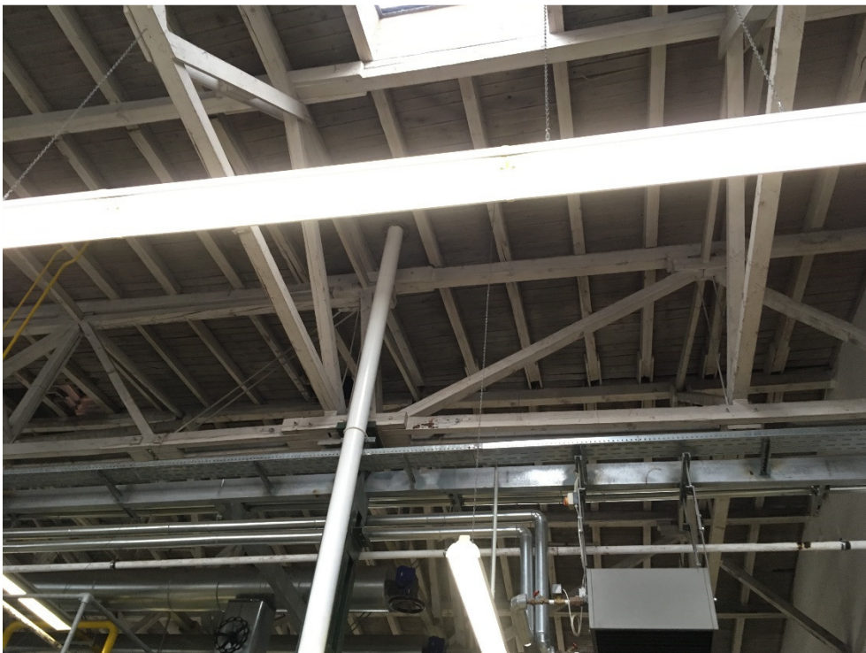
Abb. 18: Kesselhaus, Anlage Nr. 6, Dachkonstruktion
