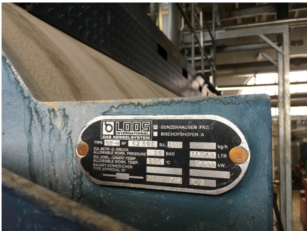
Abb. 16: Kesselhaus, Anlage Nr. 6, Kesseltyp
