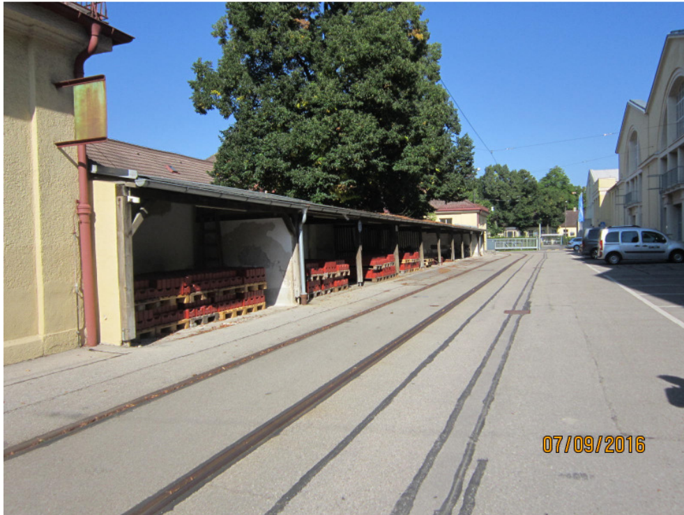
Abb. 1: Fahrradschuppen, Anlage Nr. 1
