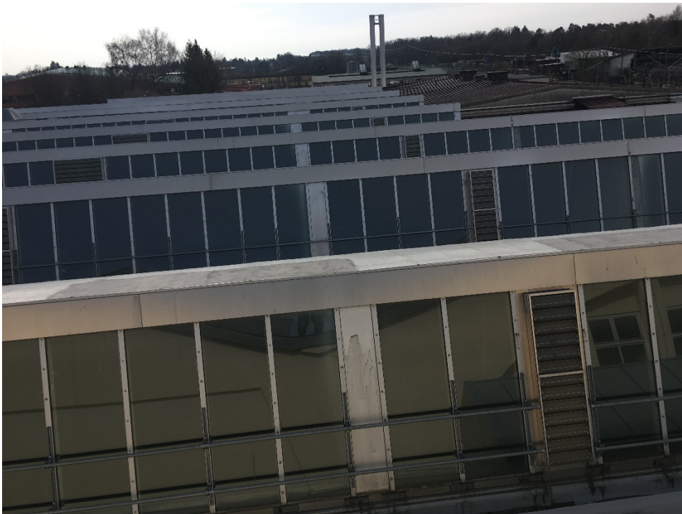
Abb. 8: Hauptwerkstätten (Shedhallen), Anlage Nr. 4, Sheddächer
