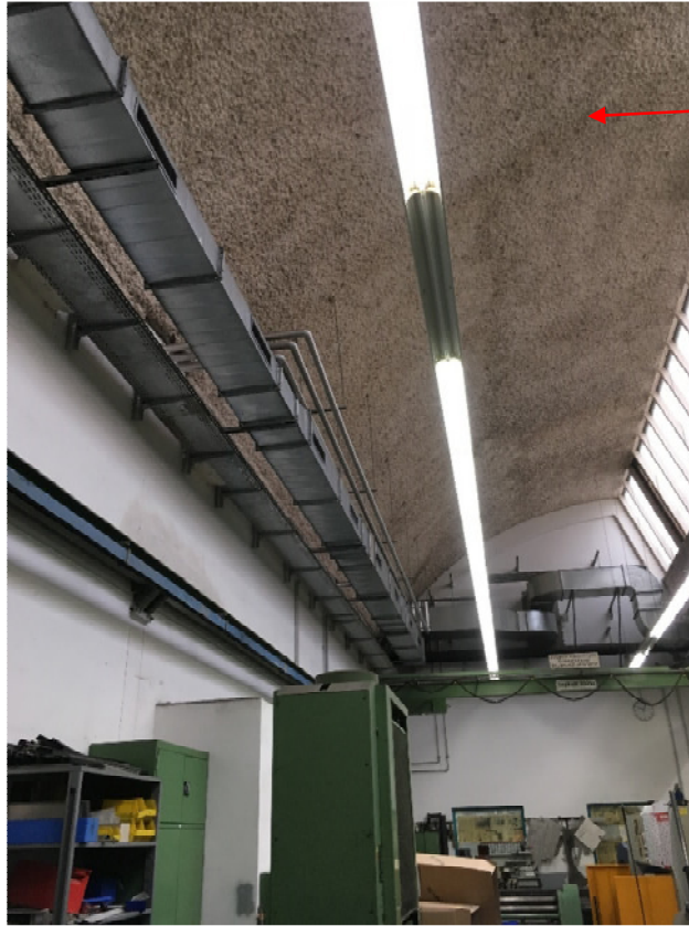
Abb. 7: Hauptwerkstätten (Shedhallen), Anlage Nr. 4, Werkstätten mit Schallschutz (asbestfrei)
