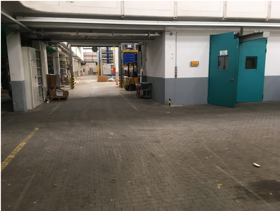
Abb. 11: Hauptwerkstätten (Montagehalle), Anlage Nr. M/4, Holzstöckelboden
