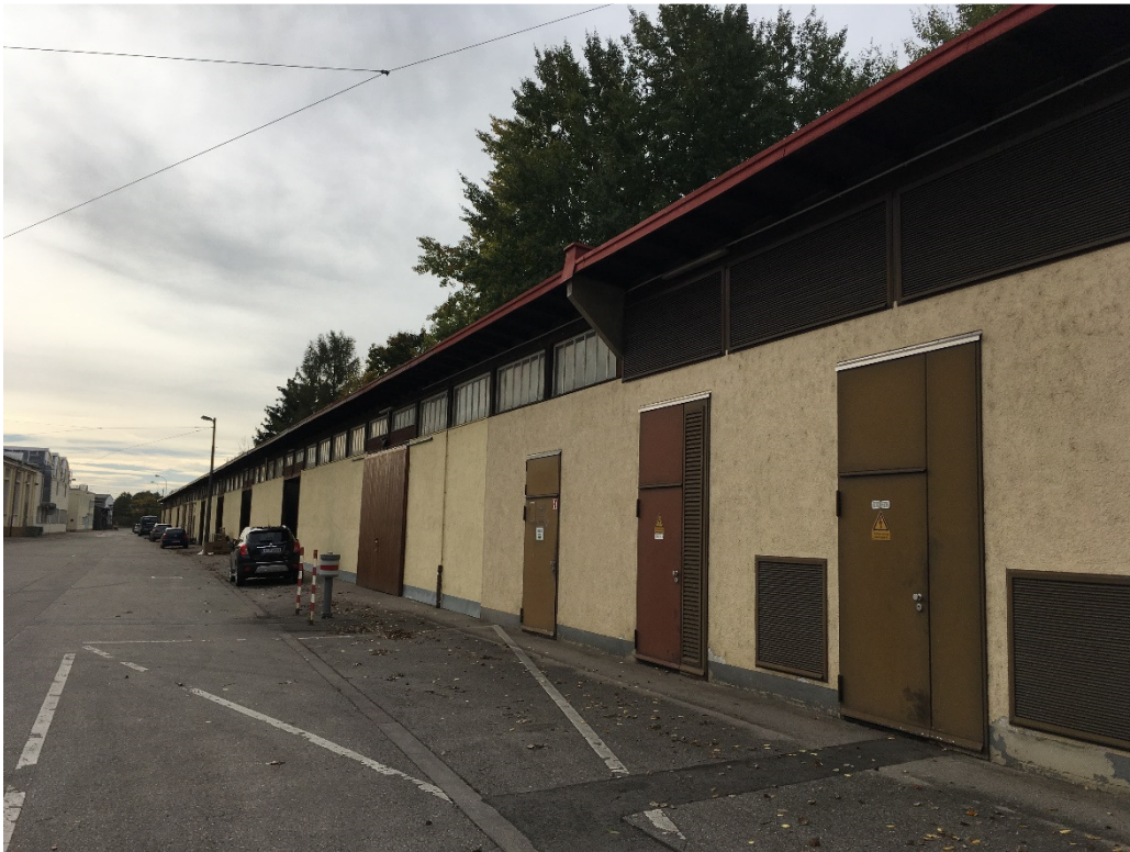
Abb. 1: Garagenbauwerk / Schuppen Nr. 3
