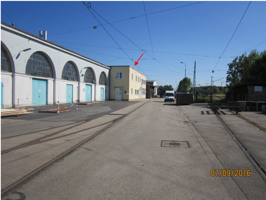
Abb. 3: Nebenbetrieb Automaten Büro Nr. 7
