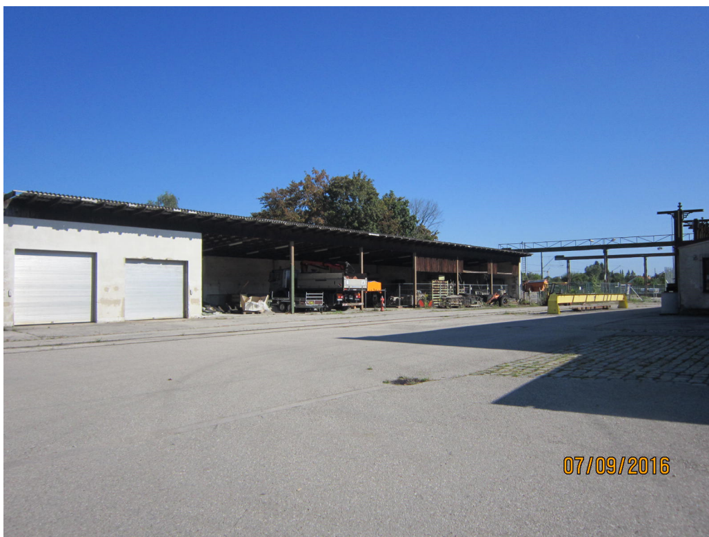
Abb. 12: Lagerhalle / Garage Nr. 20
