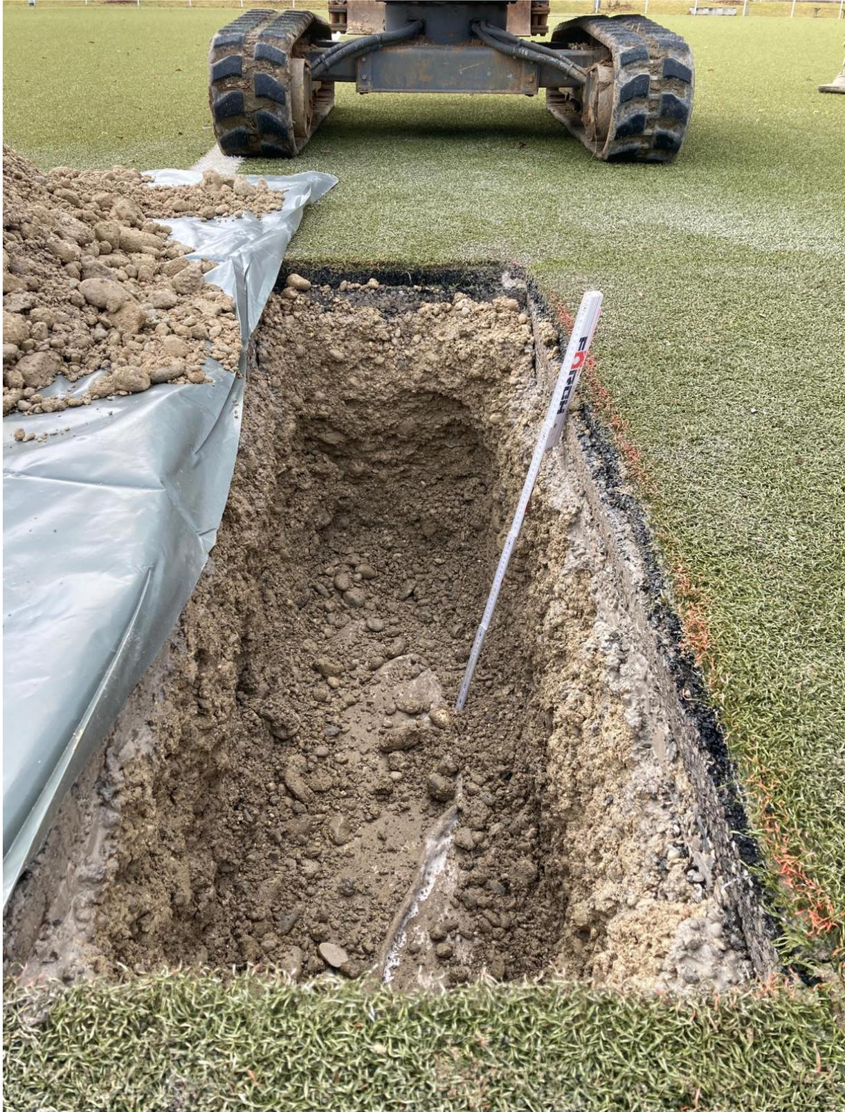
Abb. 3: Erkundungsschurf Abdeckung Altlast
