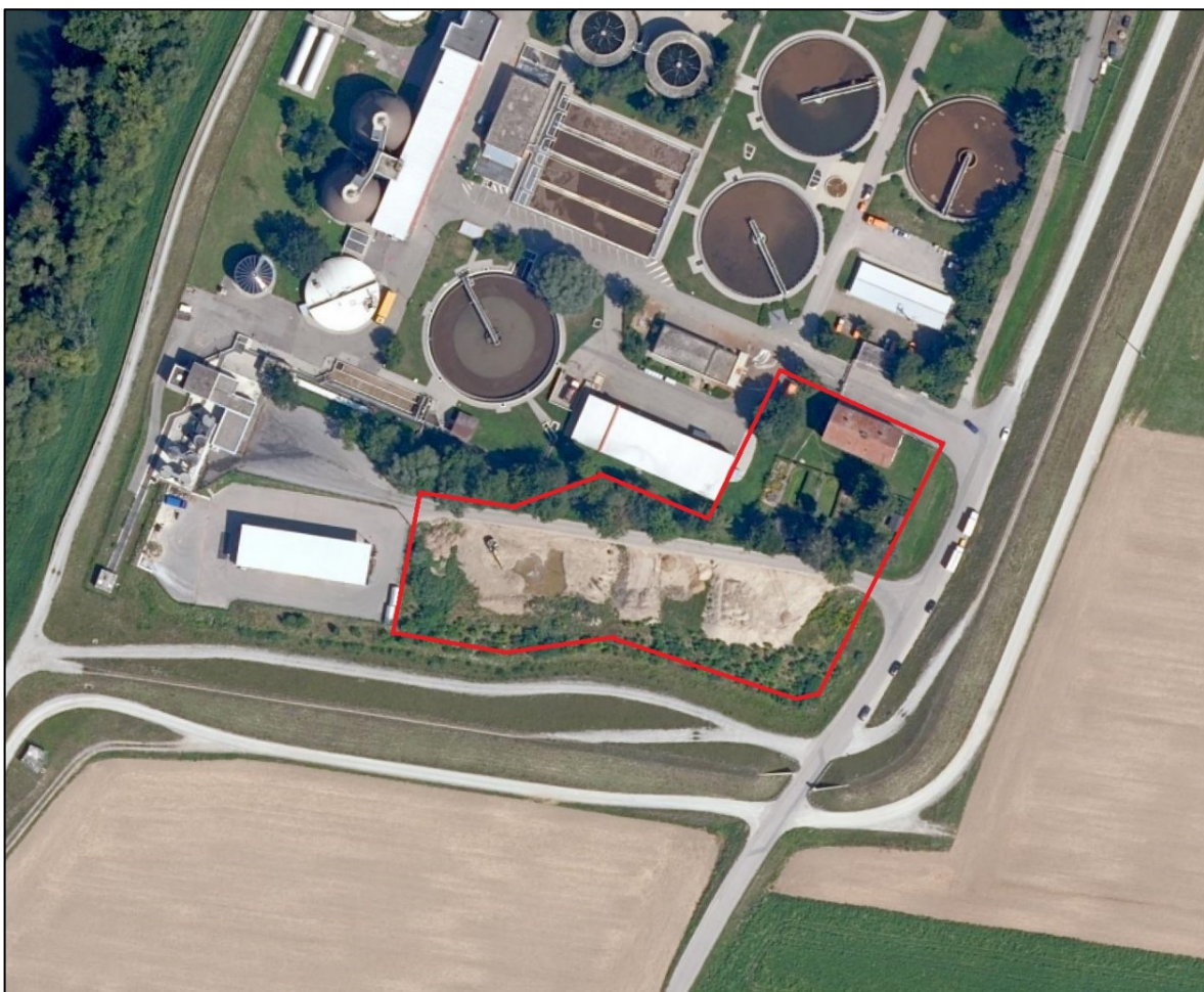
Abbildung 1: Luftbild des Standorts, geplante Fläche der KVA Straubing
