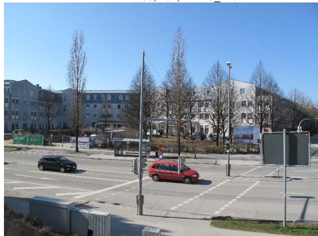
Foto 33: (FP51) KP 2 Freischützstr./JK-Str. - Ri Südwest von li nach re G_020 bis G_050.
