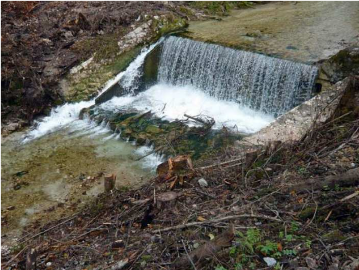
Bild Sohlabsturz beim geplanten Kraftwerksstandort
