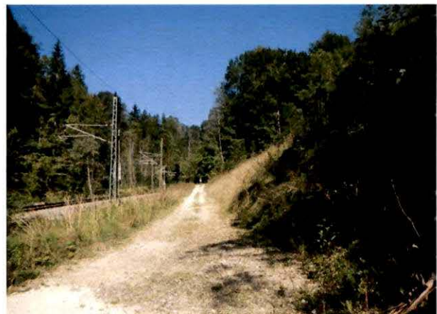
Abbildung 18: neu angelegter Zugangsweg nördlich des Gebäudes (bereits hergestellt)
