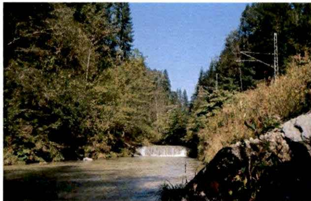
Abbildung 11: Bischofswiesener Ache Querbauwerk Nr. 4
