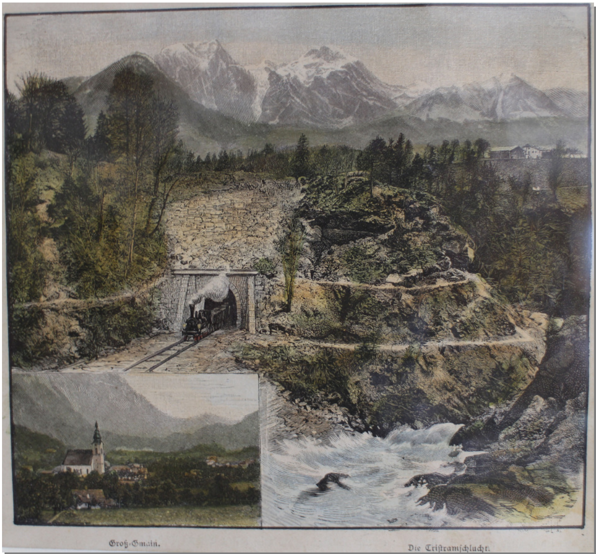
Abb. 6 Reichsbahntunnel im Bereich der Tristramschlucht, Steinschichtung aus Bruchsteinquadern und Felspalfen aus Konglomerat erkennbar. Holzstich, 1880
