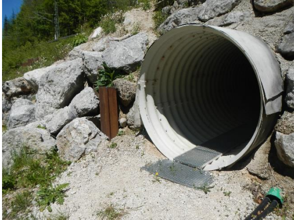
Abbildung 1.9: Hergestellter Durchgang in Form einer DN 2000 Verrohrung
