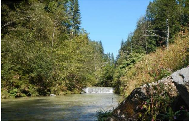
Abbildung 1.3: Bischofswiesener Ache Querbauwerk Nr. 4
