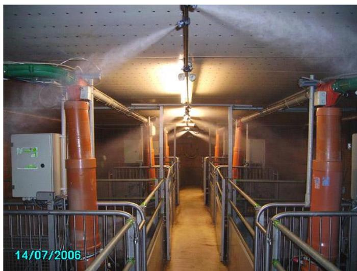
Abbildung 11 Blick in Stallung mit Sprühnebelanlage
