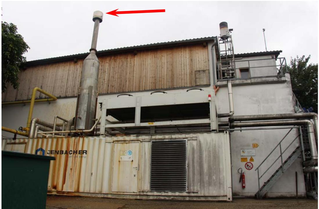
Foto 7: Blick in Richtung Süden auf den Stahlblech-Container der „kleinen“ Biogas- und BHKW-Anlage. Der Pfeil kennzeichnet die Abgasmündung des BHKW-Moduls.
