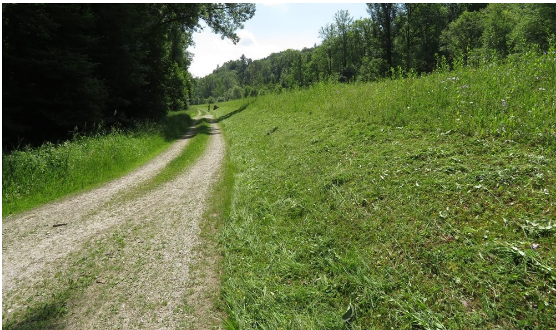
Abb. 10: Blick auf die frisch gemähte wasserseitige Deichböschung bei Fkm 25,3 Richtung Süden.
