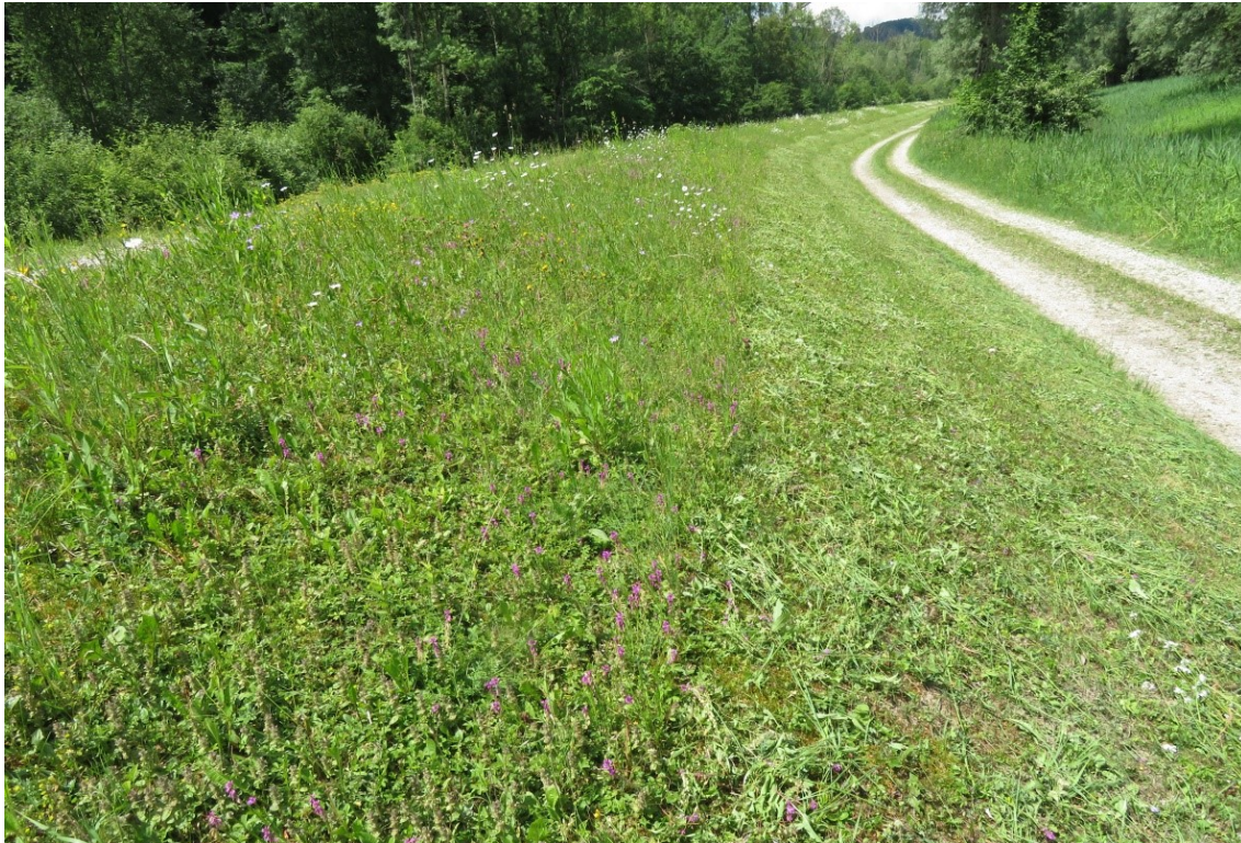
Abb. 11: Blick auf die wasserseitige Deichböschung bei Fkm 26,0 Richtung Nordwesten.
