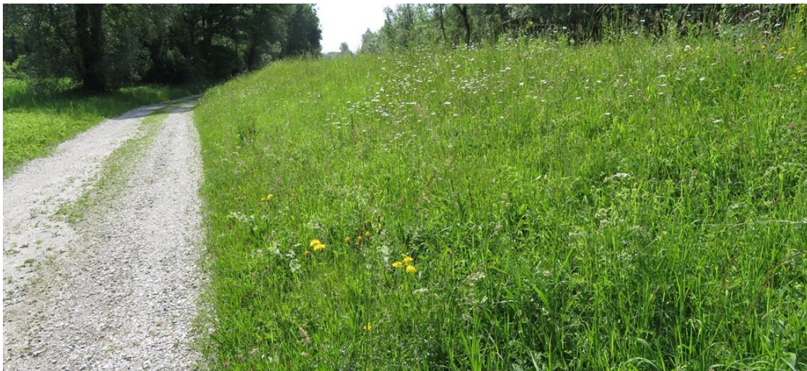
Abb. 8: Blickrichtung Südwesten auf die wasserseitige Deichböschung bei Fkm 26,0.
