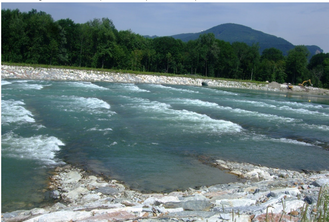
Abb. 2: Aufgelöste Sohlrampe im Freilassinger Becken bei Fkm 51,9 (Foto SKI)
