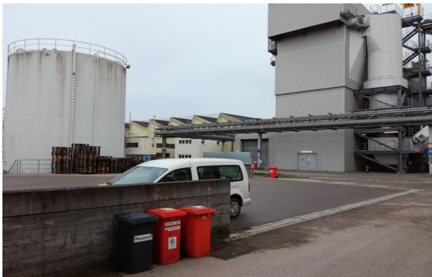
Abbildung 3- Geplanter Standort (Öltanklager noch nicht abgerissen) mit EBS-Heizkraftwerk im Hintergrund
