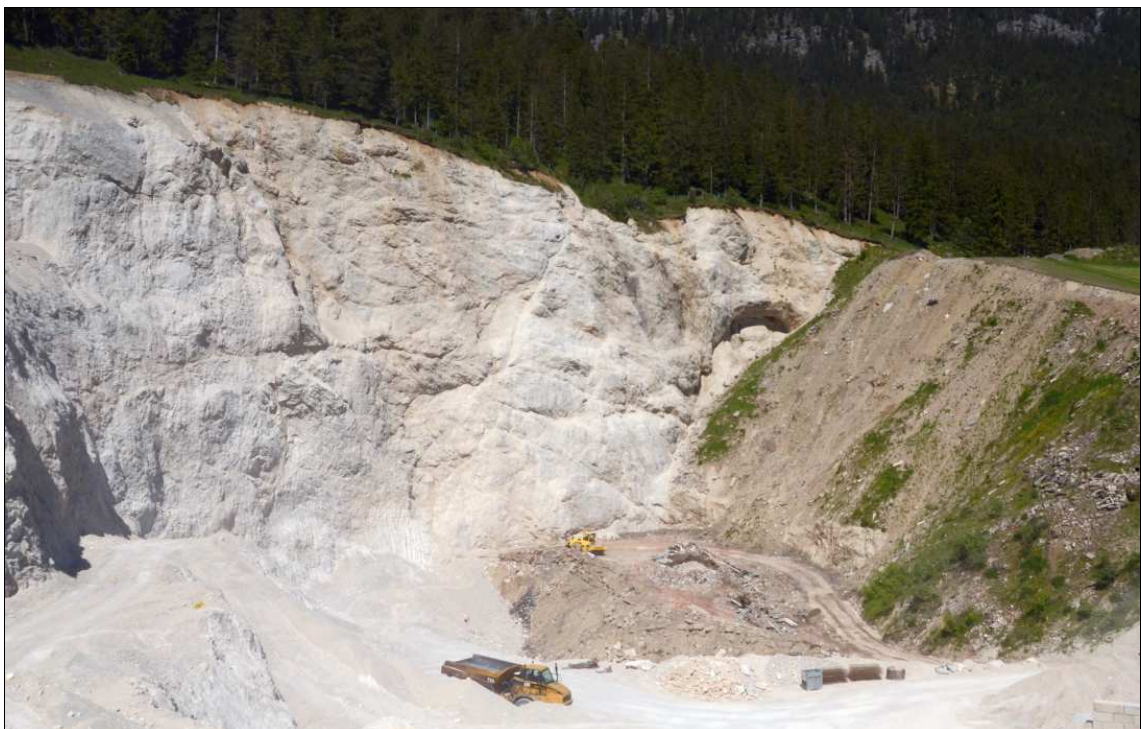
Abbildung 6: Foto des Steinbruchs und der Wiederverfüllung – Vergleich Schnitt Abbildung 4
