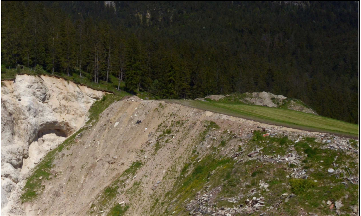
Abbildung 7: Foto der begrünten Deponiefläche – im Vordergrund die Böschung zum Steinbruch
