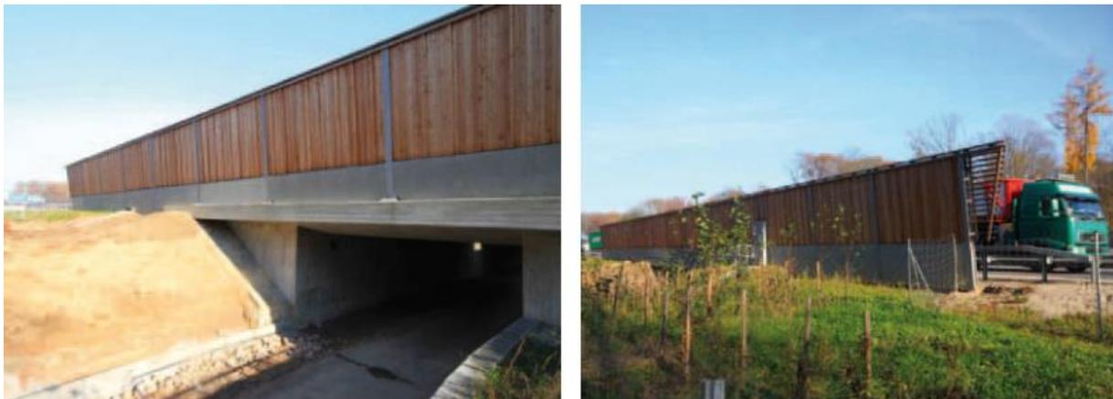
**Abb. 3:** Beispiel für Irritationsschutzwände (BAB A 5 bei Offenburg). Die Sperreinrichtung reicht ca. 25 m über das Bauende des Wildtierdurchlasses (hier kombiniert mit einem Radweg) hinaus. Die Weite (8 m) und Höhe (ca. 3 m) lassen eine Annahme durch die meisten strukturgebunden fliegenden Fledermausarten erwarten. Auf dem Bild fehlt noch die geplante und zwingend erforderliche Bepflanzung als Leitstruktur (Quelle: BRINKMANN et al. 2012).
