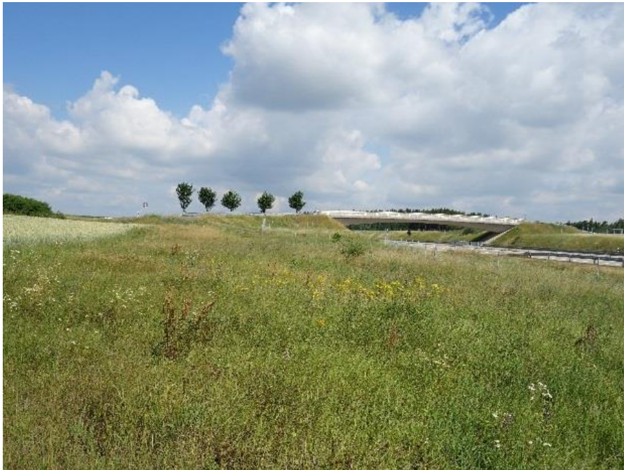
Blick auf der Rastanlagen-Westseite in Richtung Norden zur Feldweg-ÜF © WGF Landschaft 2017
