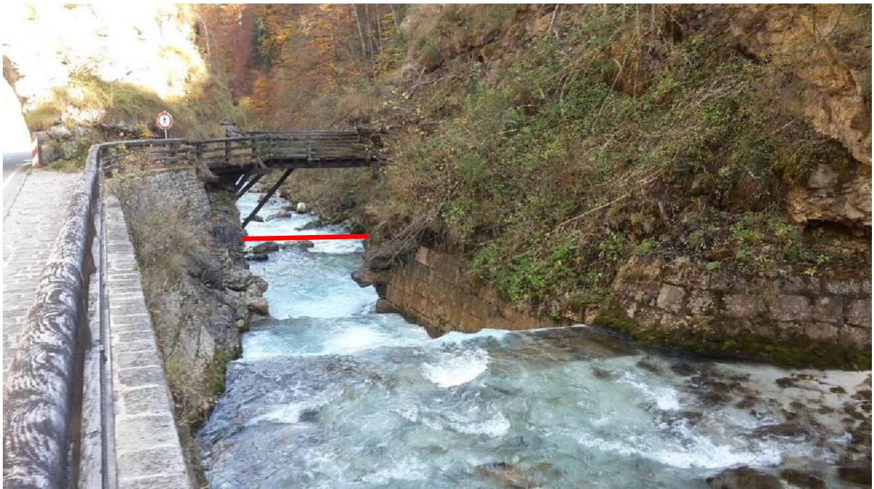
Abb. 11: Blick von oberhalb auf den Doppelabsturz am Fluss-km 6+100 (Abschnitt 64a) in der Ramsauer Ache oberhalb des geplanten Stauwehres (rote Linie), wo die gewässerökologische Durchgängigkeit durch den Einstau hergestellt werden soll (Foto: 02.08.2017)
