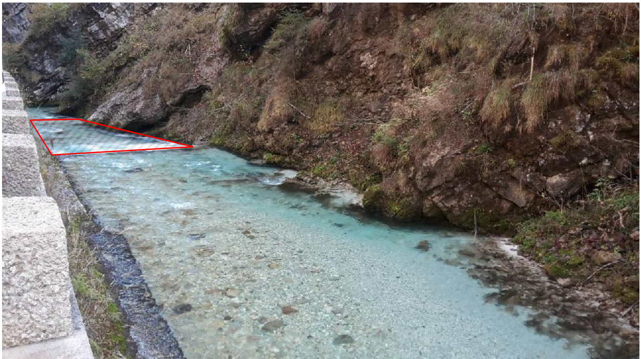
Abb. 15: Blick von oberhalb auf den Sohlabsturz am Fluss-km 6+245 (Abschnitt 65d) in der Ramsauer Ache, wo die gewässerökologische Durchgängigkeit durch Ausbildung einer natürlichen Sohlgleite (schraffierte Fläche) hergestellt werden soll (Foto: 20.10.2017)
