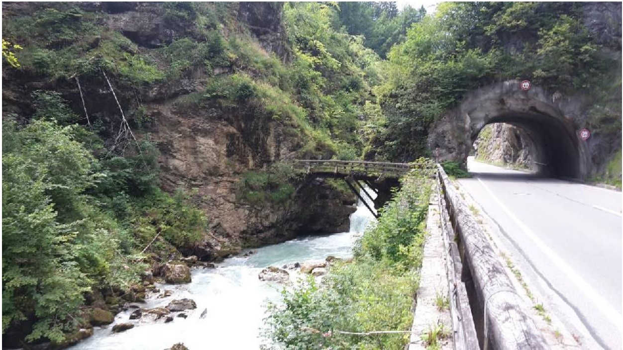
Abb. 6: Blick auf den geplanten Standort der WKA Felsentunnel an der Ramsauer Ache von unterhalb entgegen der Fließrichtung (Foto: 02.08.2017)
