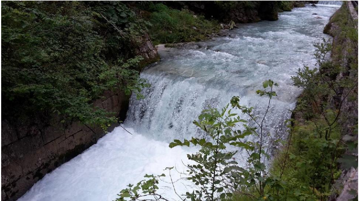
Abb. 10: Blick von unterhalb auf den oberen Absturz des Doppelabsturzes am Fluss-km 6+100 (Abschnitt 64a) in der Ramsauer Ache oberhalb des geplanten Stauwehres, wo die gewässerökologische Durchgängigkeit durch den Einstau hergestellt werden soll (Foto: 02.08.2017)
