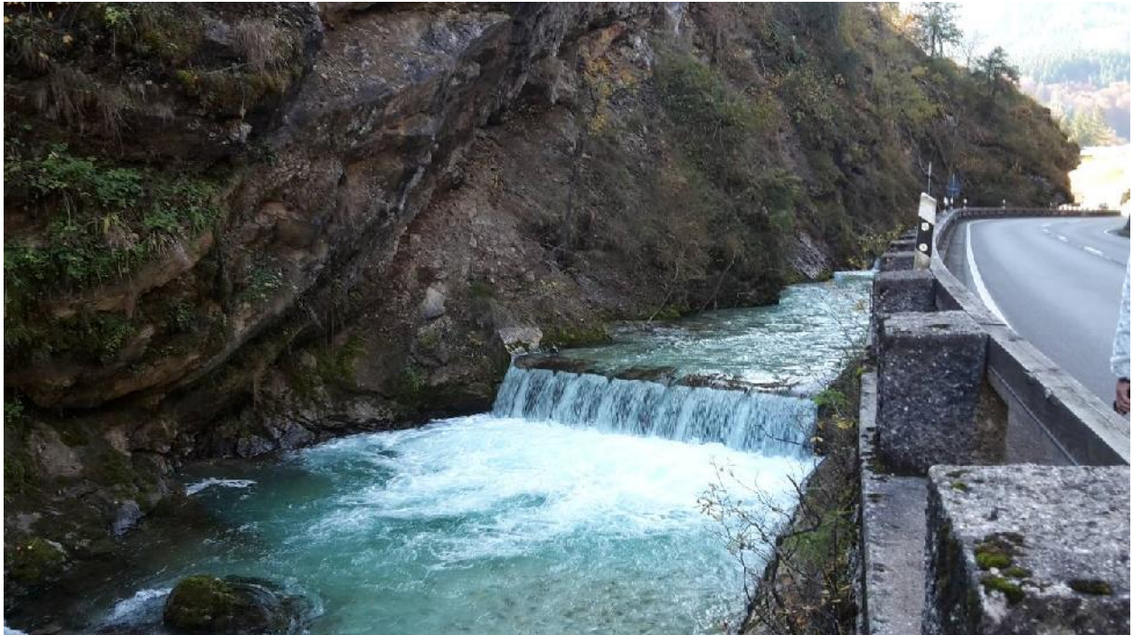
Abb. 12: Blick von unterhalb auf den Sohlabsturz am Fluss-km 6+180 (Abschnitt 65a) in der Ramsauer Ache unmittelbar oberhalb des geplanten Einstaubereiches, wo die gewässerökologische Durchgängigkeit durch Ausbildung einer natürlichen Sohlgleite hergestellt werden soll (Foto: 20.10.2017)
