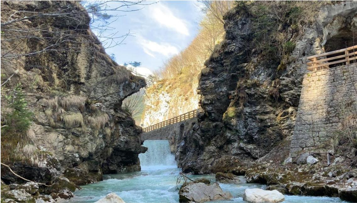
**Abbildung 17 Stark klüftiges Gestein am Felsentor (östliche Seite), rechts im Bild; überhängende Felsbereiche links im Bild, Blickrichtung SW**
