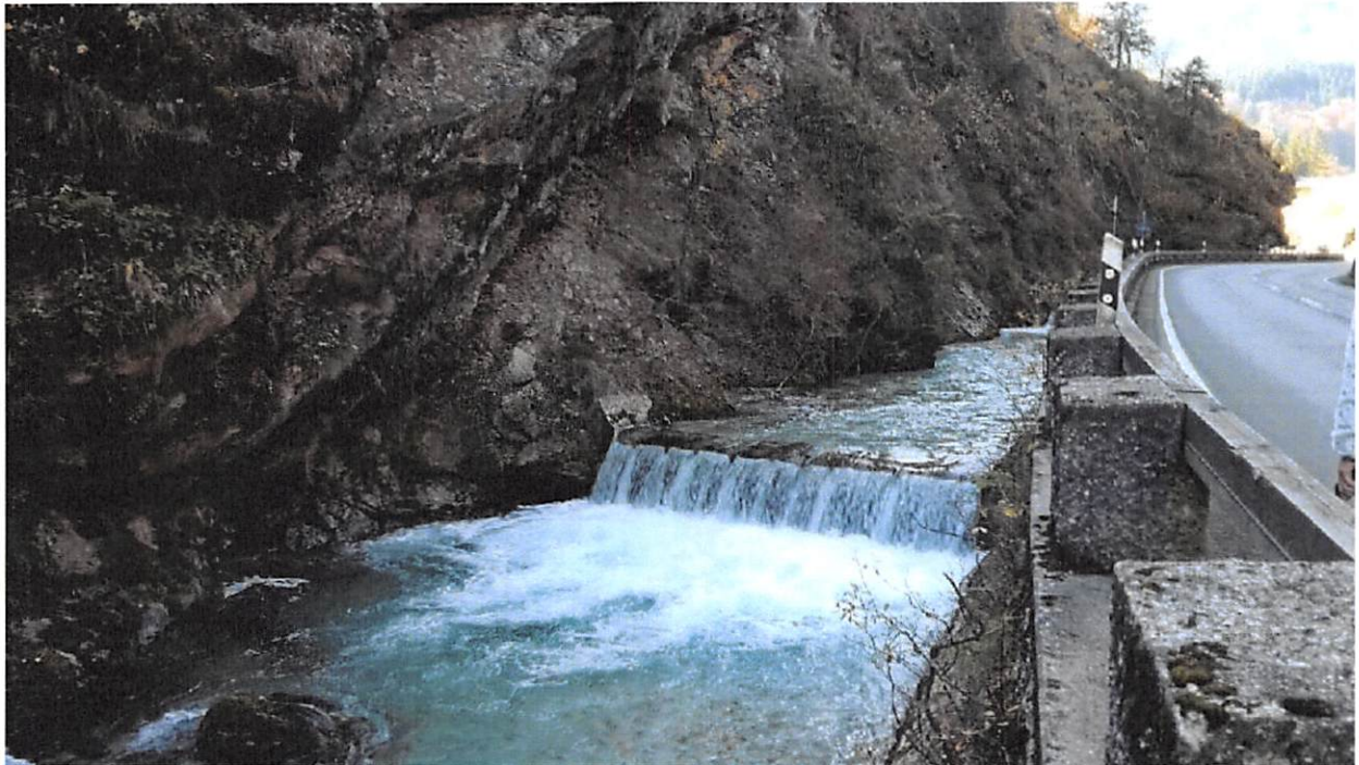
Abb. 9: Blick von unterhalb auf den Sohlabschurz am Fluss-km 6+180 (Abschnitt 65a) in der Ramsauer Ache unmittelbar oberhalb des geplanten Einstaubereiches, wo die gewässerökologische Durchgängigkeit durch Ausbildung einer natürlichen Sohlgleite hergestellt werden soll (Foto: 20.10.2017)
