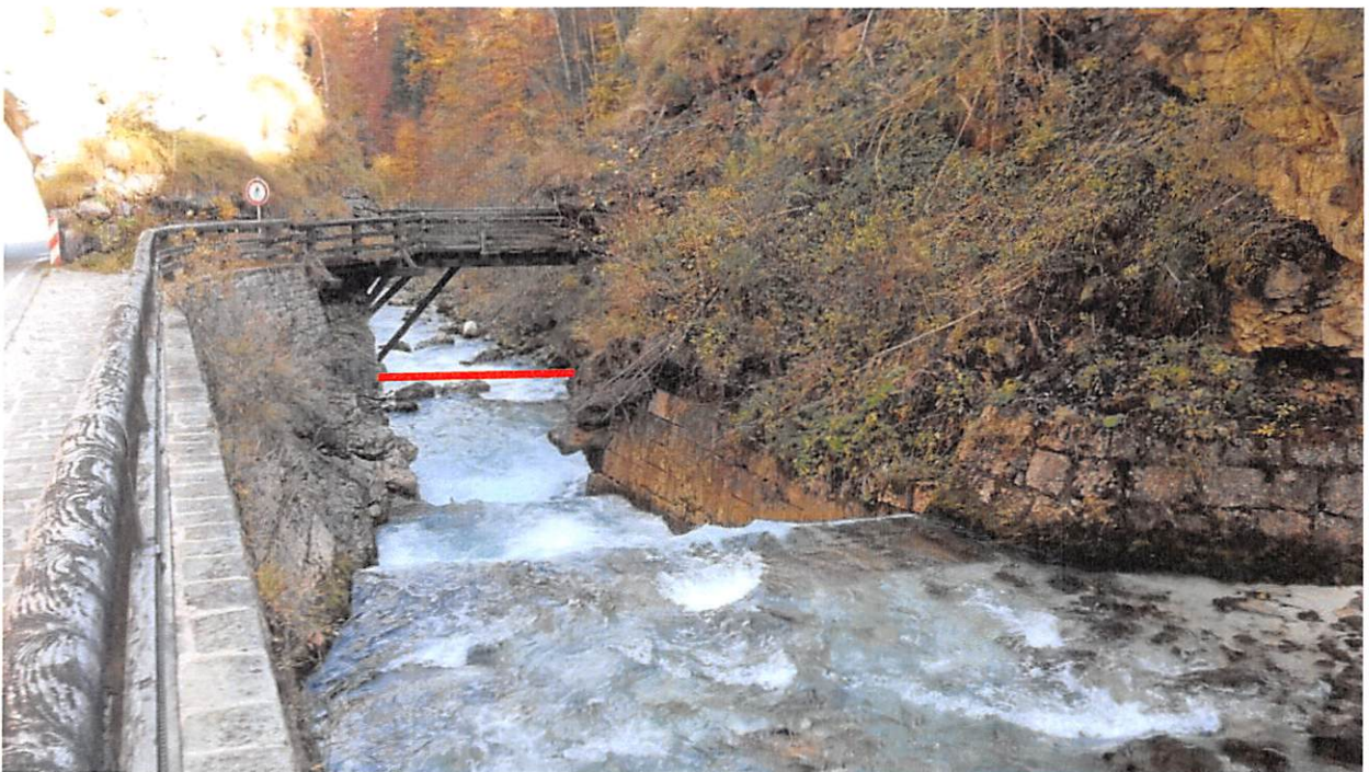
Abb. 8: Blick von oberhalb auf den Doppelabsturz am Fluss-km 6+100 (Abschnitt 64a) in der Ramsauer Ache oberhalb des geplanten Stauwehres (rote Linie), wo die gewässerökologische Durchgängigkeit durch den Einstau hergestellt werden soll (Foto: 02.08.2017)
