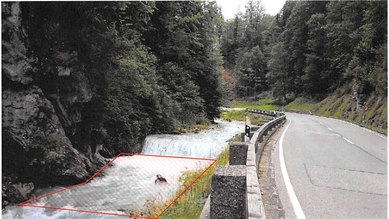
Abb. 13: Blick von unterhalb auf den Sohlabsturz am Fluss-km 5+773 (Abschnitt 60c) in der Ramsauer Ache, wo die gewässerökologische Durchgängigkeit durch Ausbildung einer natürlichen Sohlgleite (schraffierte Fläche) hergestellt werden soll (Foto: 02.08.2017)
