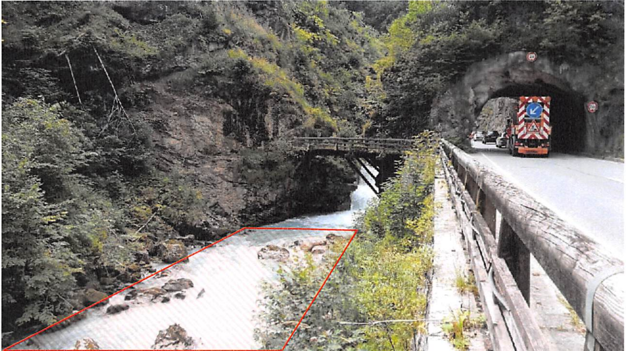
Abb. 6: Blick stromauf auf den geplanten Standort (schraffierte Fläche) des Stauwehres einschließlich Tosbecken und Gegenschwelle in der Ramsauer Ache unmittelbar unterhalb des Felsentores (Foto: 02.08.2017)
