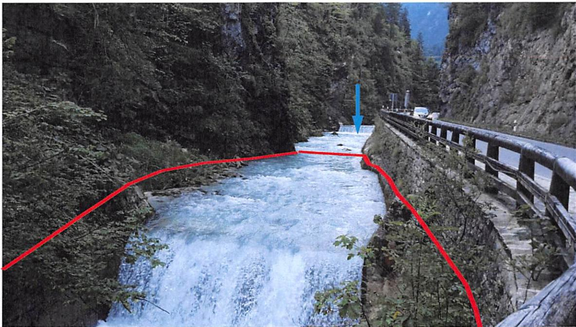
Abb. 5: Blick von unterhalb entgegen der Fließrichtung auf den geplanten Einstaubereich des Wehres (rote Linie = betriebsphase bei Stau) oberhalb des Felsentunnels an der Ramsauer Ache, im Hintergrund (Pfeil) die Sohlstufe bei km 6+180, die durch Schaffung einer natürlichen bzw. naturnahen Sohlgleite (Länge: ca. 20 m) oberhalb des Rückstaubereiches durchgängig gestaltet wird (Foto: 20.10.2017)
