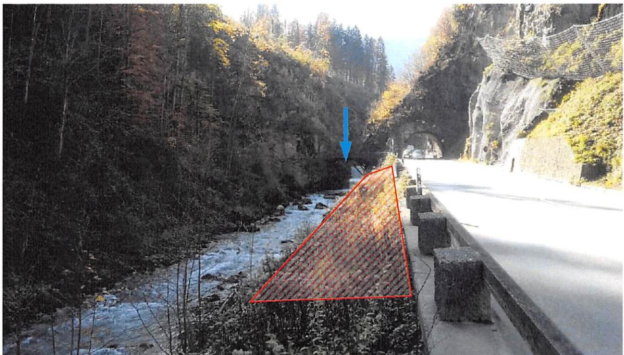
Abb. 4: Blick von unterhalb entgegen der Fließrichtung auf den geplanten Standort der WKA Felsentunnel an der Ramsauer Ache (Pfeil), linksufrig zwischen Bundesstraße und Ramsauer Ache (Bereich regelmäßiger Unterhaltung, wo Jungwuchs an Gehölzen und krautige Vegetation regelmäßig beseitigt wird) ist auf einer Länge von ca. 60 m die Errichtung der Fischaufstiegsanlage (schraffierter Bereich) unterhalb des regulierbaren Stauwehres vorgesehen (Foto: 20.10.2017)
