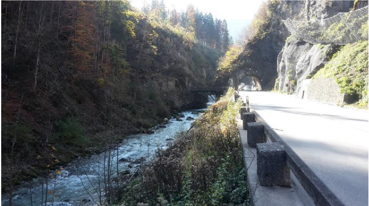
Abb. 7: Blick von unterhalb entgegen der Fließrichtung auf die vorgenommenen Felsvernetzungen einschließlich Errichtung Fangzaun am Felsentor oberhalb entlang der B 305 unmittelbar neben dem geplanten Standort der WKA Felsentunnel an der Ramsauer Ache (Foto: 20.10.2017)
