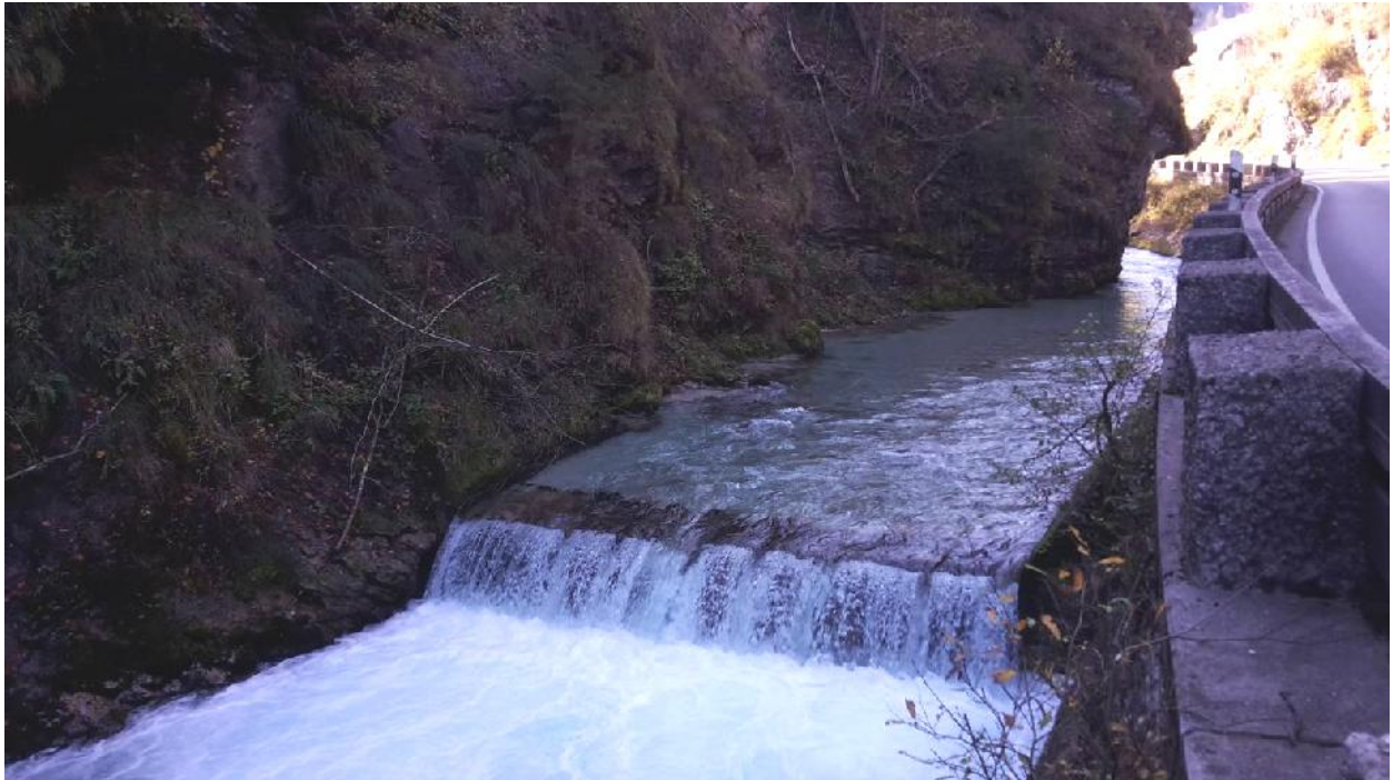
Abb. 14: Blick von unterhalb auf den Sohlabsturz am Fluss-km 6+245 (Abschnitt 65d) in der Ramsauer Ache, wo die gewässerökologische Durchgängigkeit durch Ausbildung einer natürlichen Sohlgleite hergestellt werden soll (Foto: 20.10.2017)
