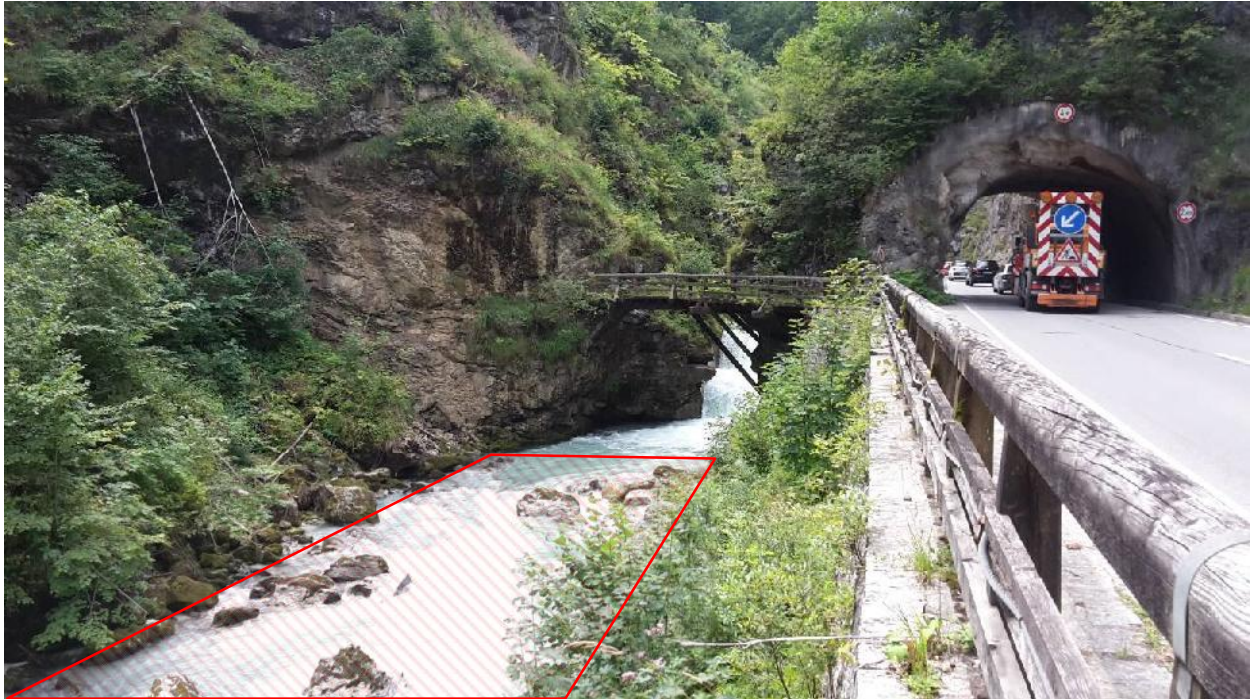
Abb. 3: Blick stromauf auf den geplanten Standort (schraffierte Fläche) des Stauwehres einschließlich Tosbecken und Gegenschwelle in der Ramsauer Ache unmittelbar unterhalb des Felsentores (Foto: 02.08.2017)
