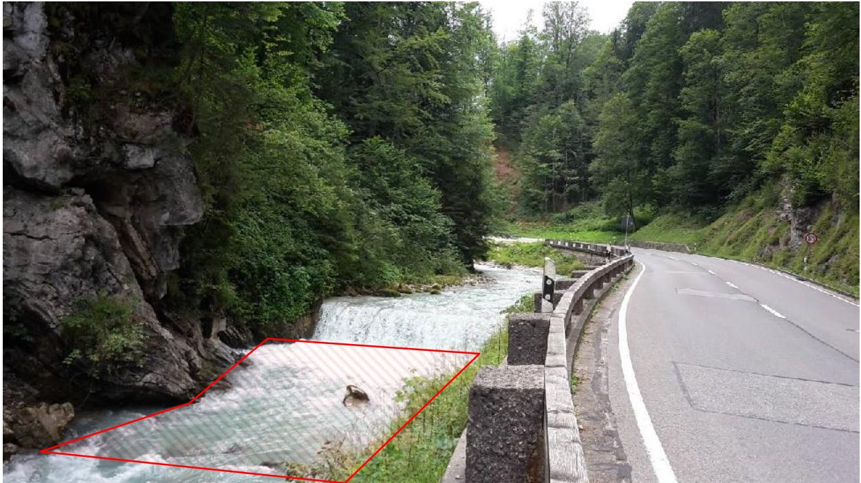
Abb. 16: Blick von unterhalb auf den Sohlabsturz am Fluss-km 5+773 (Abschnitt 60c) in der Ramsauer Ache, wo die gewässerökologische Durchgängigkeit durch Ausbildung einer natürlichen Sohlgleite (schraffierte Fläche) hergestellt werden soll (Foto: 02.08.2017)
