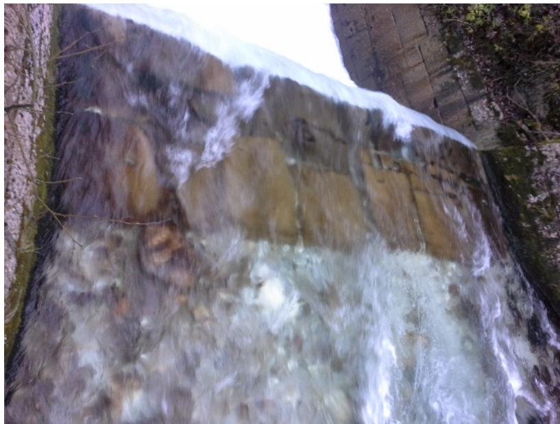
Abbildung 7: Sohlverbau vor dem Querbauwerk.
