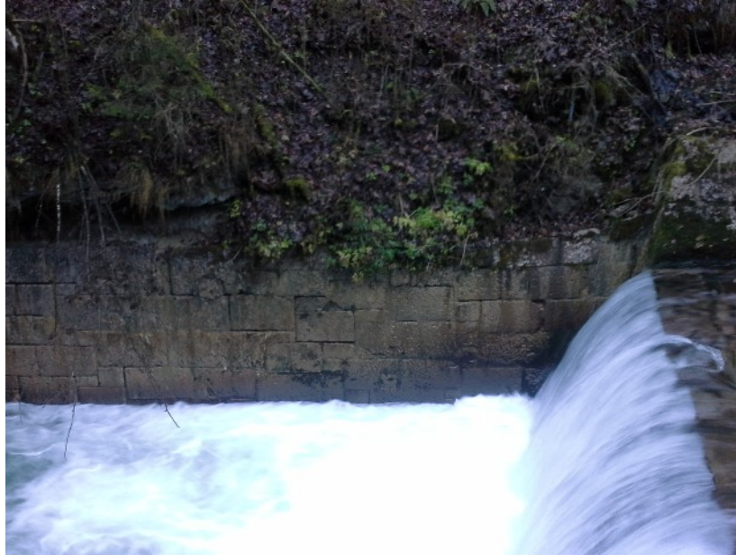
Abbildung 8: Uferverbau rechtsseitig am Felsentor.
