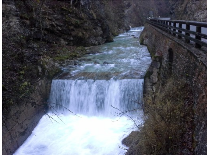
Abbildung 11: Querbauwerk unmittelbar oberhalb des Felsentores.
