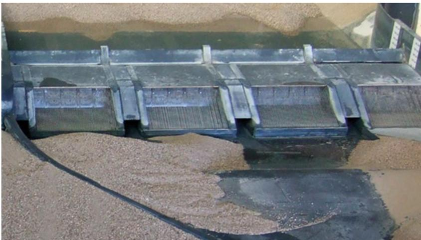
**Abb. 4** Geschiebeablagerungen im Nahbereich einer Wasserkraftanlage mit niedrigen Fallhöhen. (Brinkmeier 2012)
