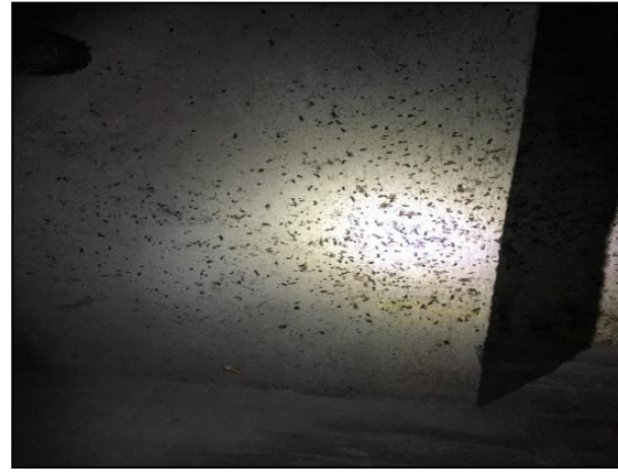
Abb. 15: Kot (relativ groß) in den Widerlagern und Hohlkästen. Aufgefunden während der Winterbegehung.
