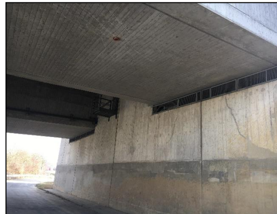
Abb. 13: Außenansicht des südlichen Widerlagers
