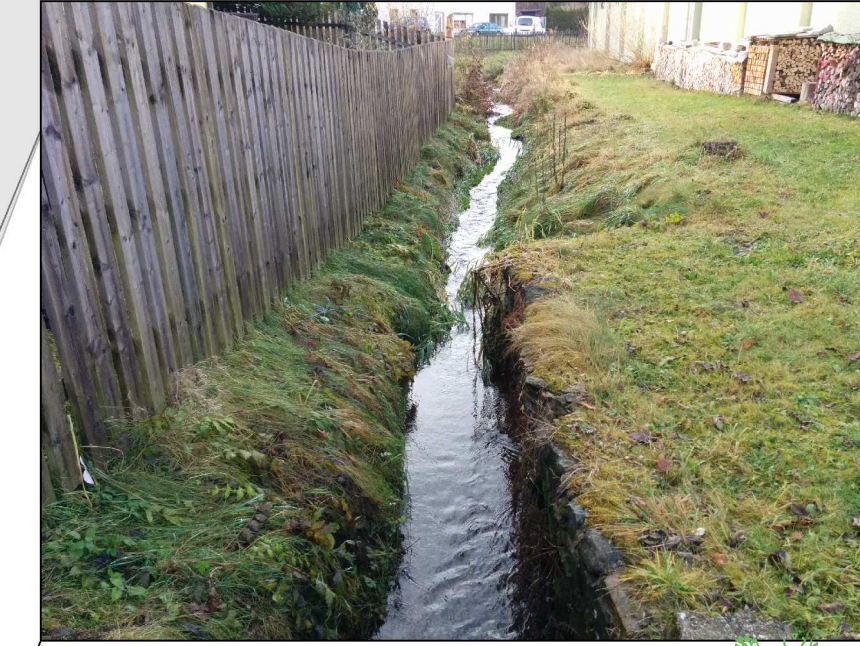
Uferverbau und bestehender Gewässerverlauf
