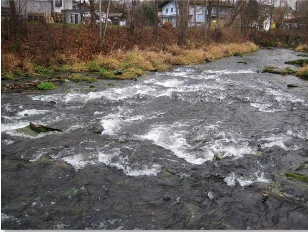
**Abb. 11:** Hydraulisch geteilte Sohlrampe
