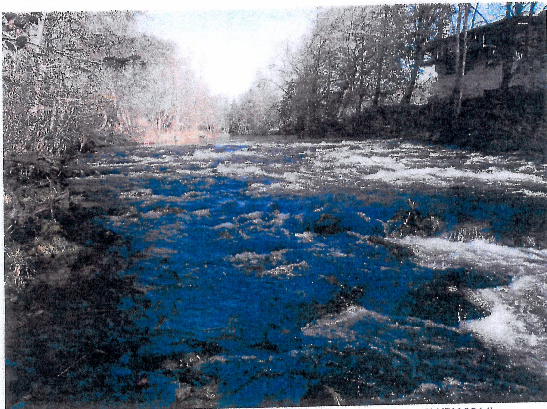
Abbildung 2: Sohlrampe, Ansicht v. unterstrom (Foto: Fachberatung für Fischerei NBY 2014)
