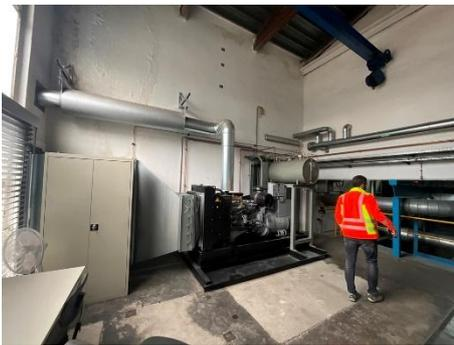
**Abb. 4: Bestehender Notstrom-Diesel**
