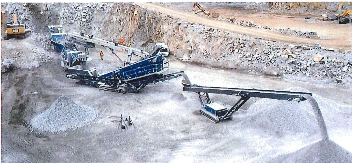
Abbildung 3: Betrieb des Anlagenzuges mit Niederdrucksprühsystem
