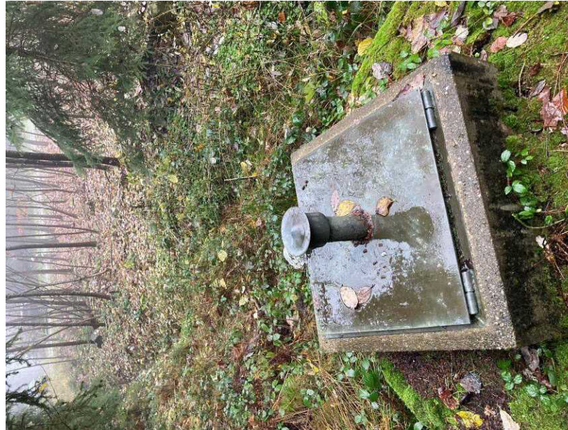
2: Sammelschacht Brauchwasserquelle
